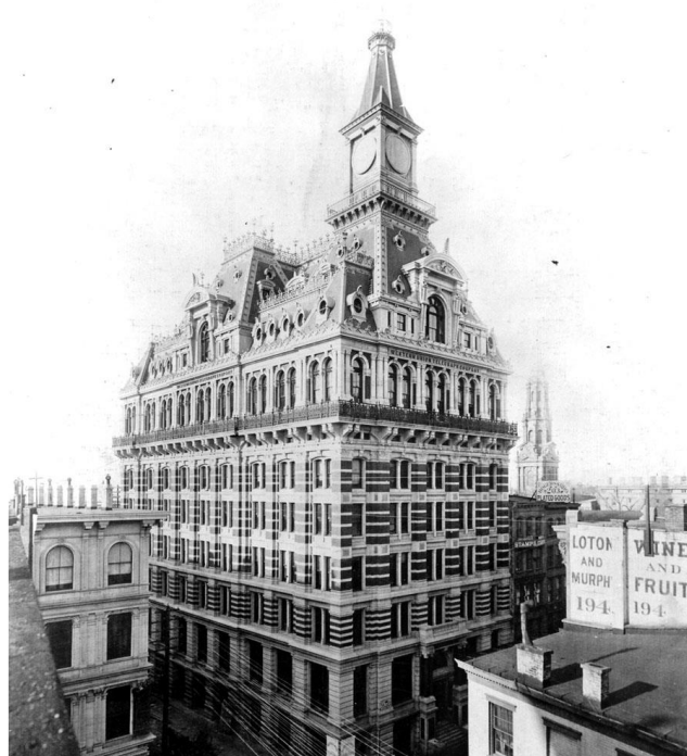
Figura 3.4 – Edifício Western Union (KHATRI, 2005, p. 3).
