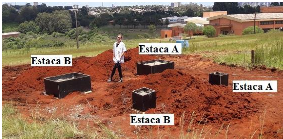
Figura 3.10: Campo experimental após a execução das estacas.
