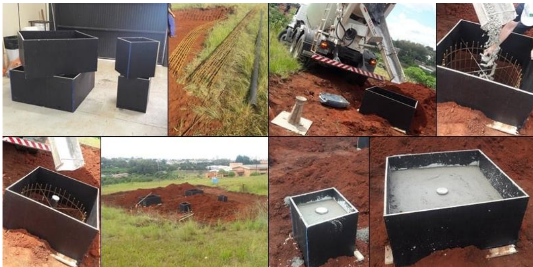
Figura 3.8: Formas de madeira, armaduras e tubos de aço carbono utilizados nas estacas, inseridos primeira para posterior concretagem das estacas.
