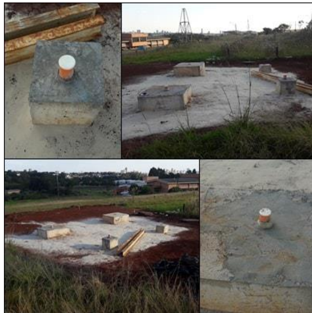
Figura 3.18: Aspecto final do campo experimental.
