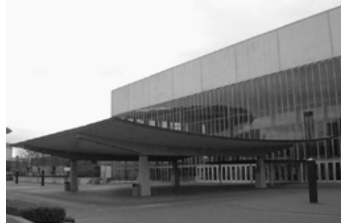
40 Vista do acesso principal.
