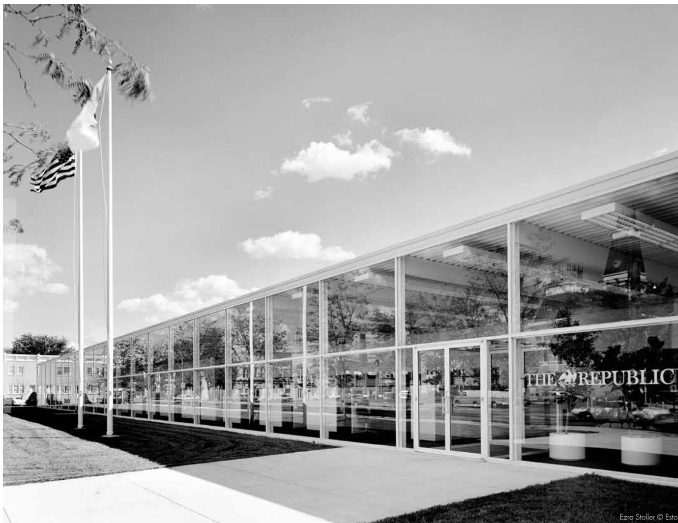
251 Vista do ingresso principal ao edifício.
