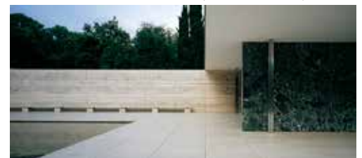
87 Mies van der Rohe. Pavilhão de Barcelona. 1929
