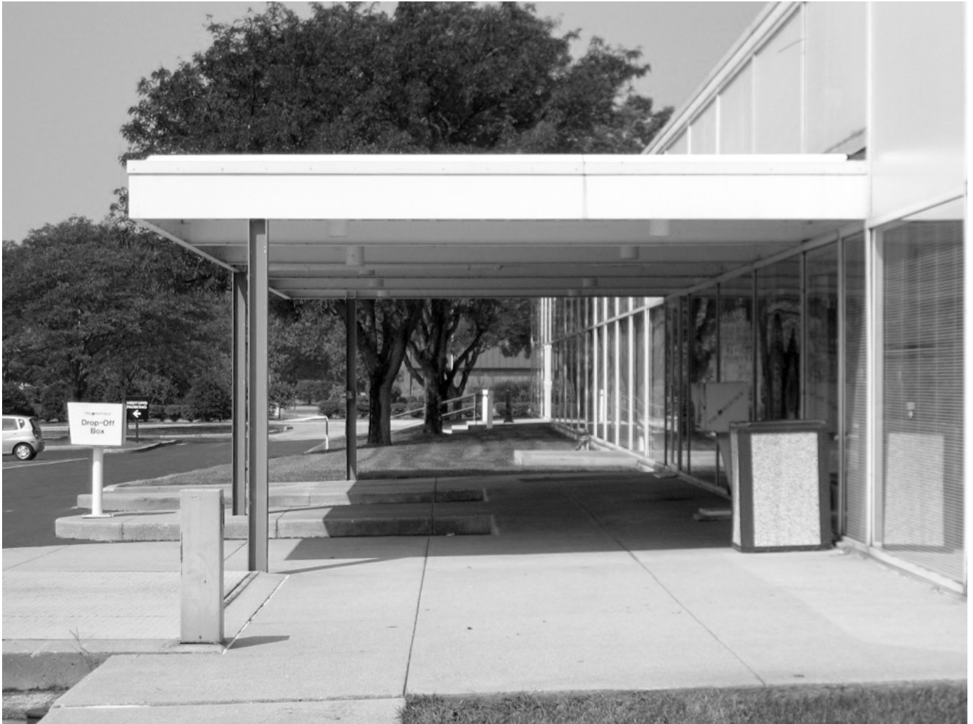
205 Vista da marquise do edifício utilizada para carga e descarga do jornal.
