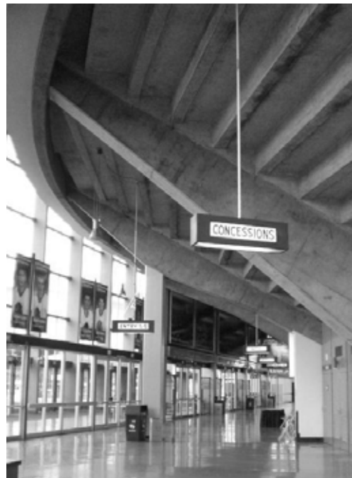
41 Vista interna em direção ao acesso principal, logo após a barreira de portas de controle.
