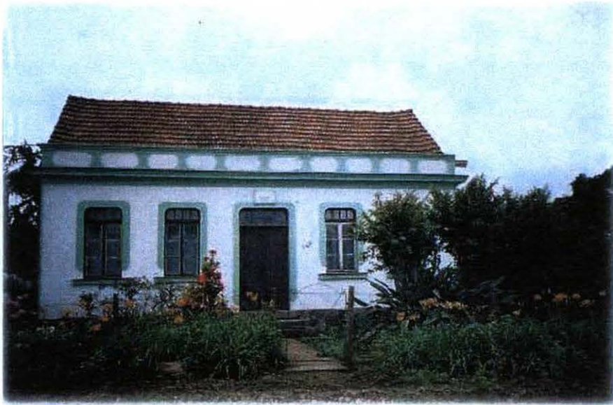
Foto nº 22: a preservação da arquitetura romântica.
