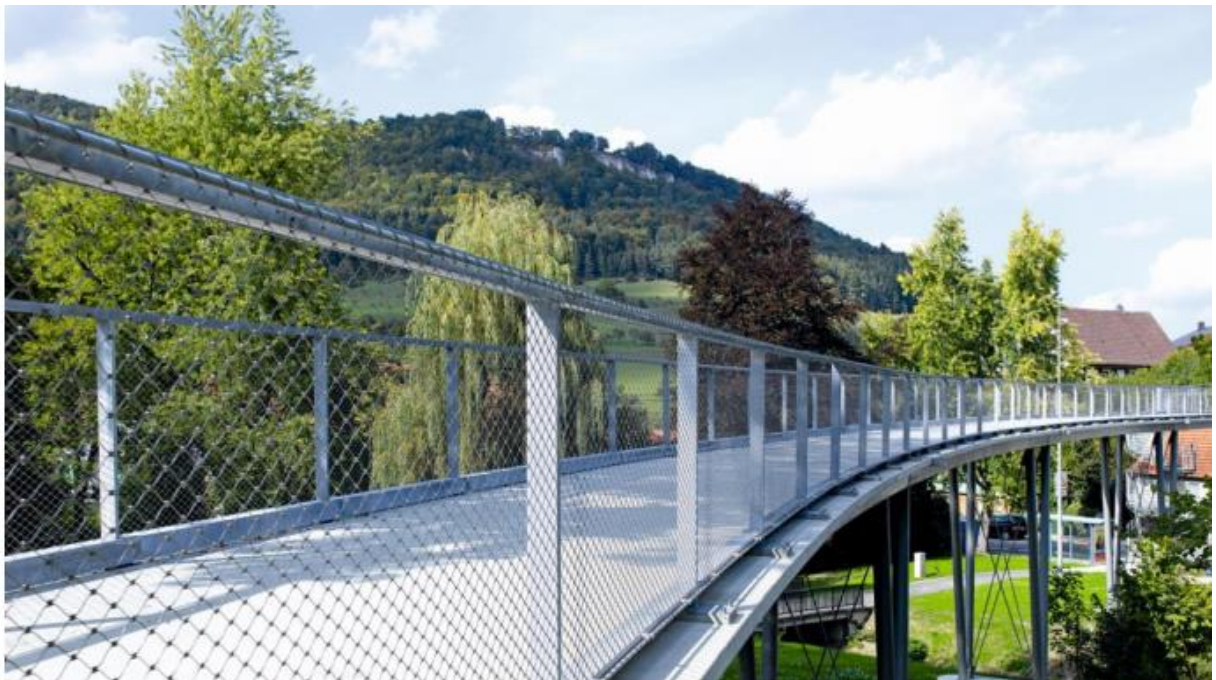
Figura 1.1 – Passarela executada combinando TRC, concreto protendido e barras não metálicas
