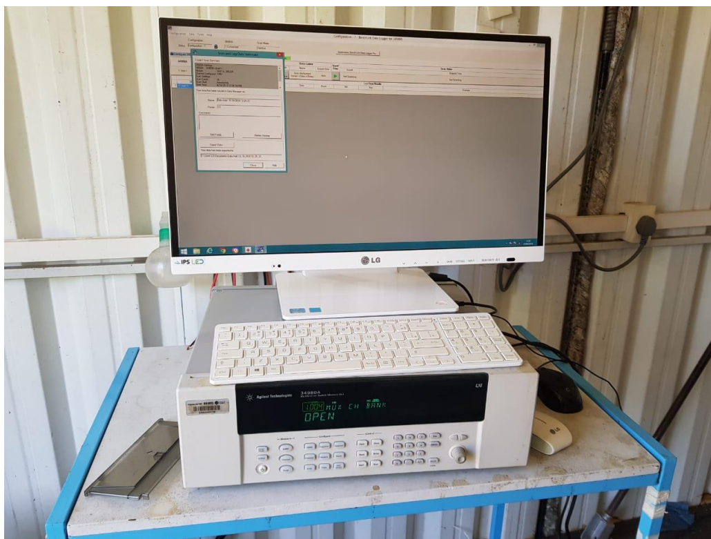
Figura 18. Computador e datalogger utilizados para a medição automática
