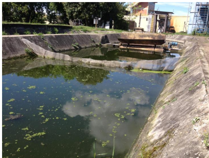
Figura 25. Macrófitas espalhadas na LAT de algas quando desligada a mistura
