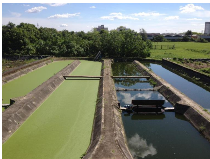
Figura 12. LAT's de algas (direita) e macrófitas (esquerda) operadas em paralelo.
