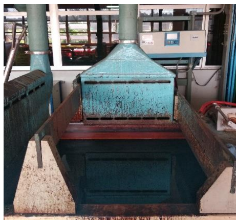
Figura 3.7 Tanque de cromo utilizado para a realização dos testes.
