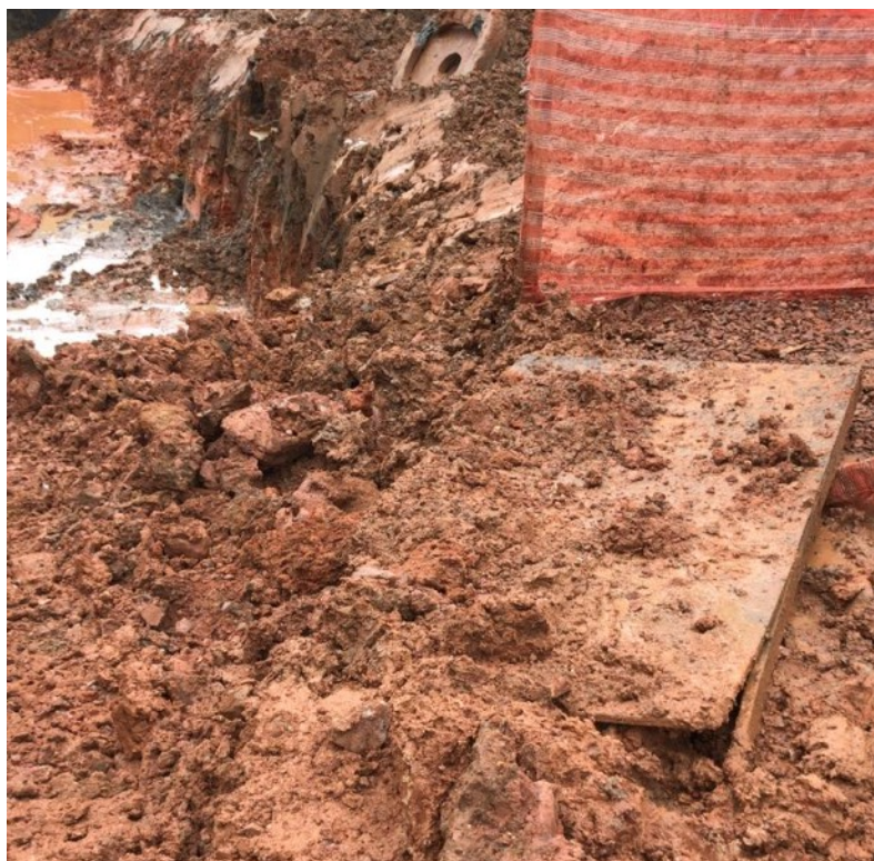
Figura 19 - Aspecto argiloso do solo
