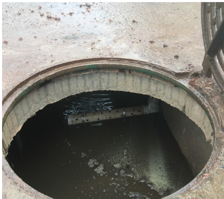
Figura 23 - Descarregador de fundo executado
