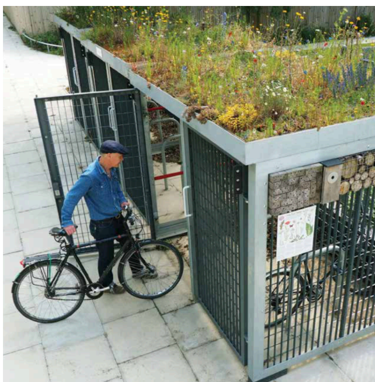
Figura 8 - Telhado verde instalado em bicicletário
