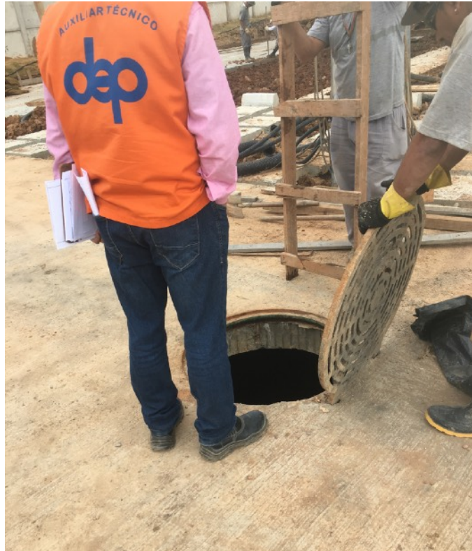
Figura 24 - Vistoria do DEP para aprovação da bacia de amortecimento
