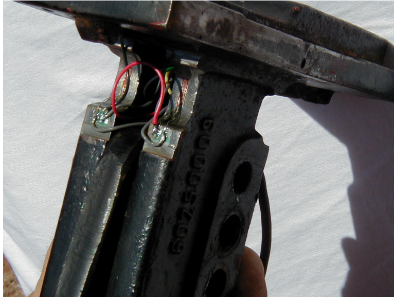
FIGURA 1. Detalhe da instalação dos estensômetros.
