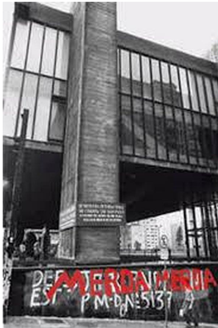
Figura 11: A “MERDA” de Bardi, na mureta do MASP, 1982. Fonte: CAKOFF, 1999 45
