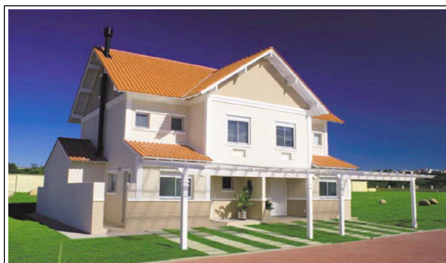
Figura 24: vista de duas unidades habitacionais geminadas do empreendimento Y1
