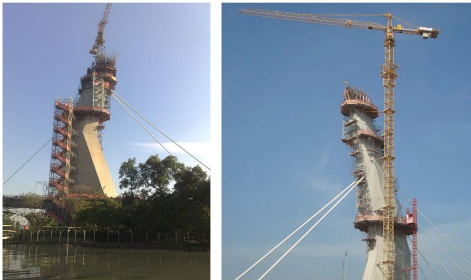
Figura 3.7 – Execução do pilone da Ponte do Saber. (GOMES, 2013; Souza JR Topografia e Engenharia, 2013)
