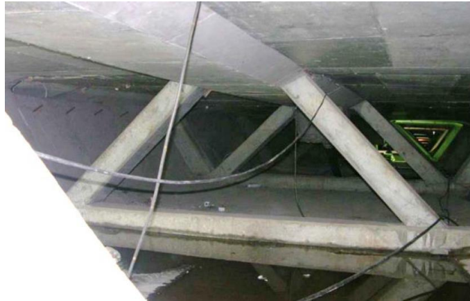
Figura 3.14 – Seções de enrijecimento projetadas no tabuleiro. (TOLEDO, 2014)
