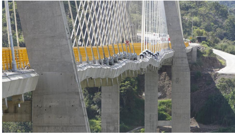
Figura 1.3 – Distorções ao longo do tabuleiro da Ponte Hisgaura. (ELTIEMPO, 2019)
