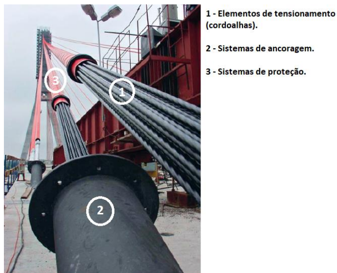
Figura 2.14 – Elementos constituintes dos estais. (adaptado de SVENSSON, 2012)
