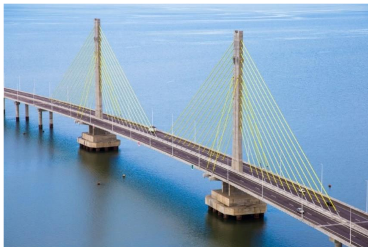
Figura 2.20 – Ponte Anita Garibaldi, Laguna – SC. (SULAGORA, 2020)
