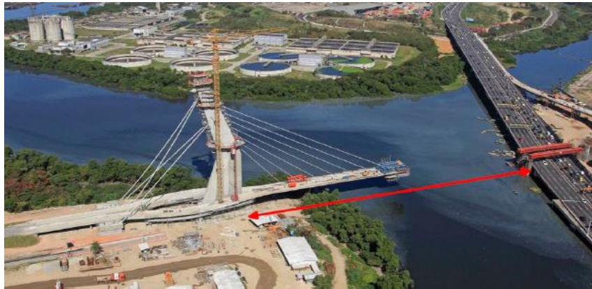
Figura 3.16 – Execução da Ponte do Saber. (LAZZARI, 2016)
