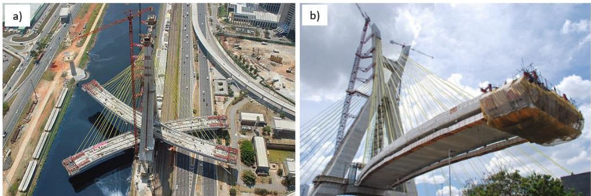
Figura 2.32 – (a, b) Construção da Ponte Octávio Frias de Oliveira. (MAZZARIM, 2011)
