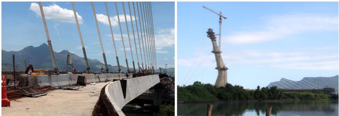
Figura 3.15 – Construção do tabuleiro pelo método dos balanços sucessivos. (GOMES, 2013)
