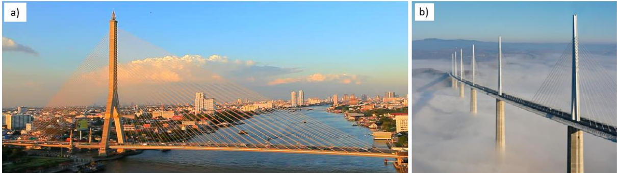
Figura 2.30 – a) Rama VIII Bridge, Tailândia; b) Viaduc de Millau, França (FREEPIK, 2018)
