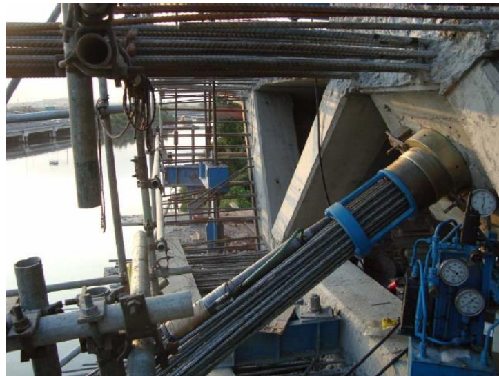
Figura 3.11 – Protensão de um estai que compõe a Ponte do Saber. (GOMES, 2013)
