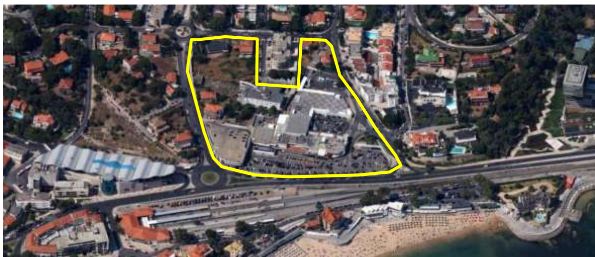
Figura 41 – Vista aérea da área de intervenção – Entrada Nascente de Cascais
