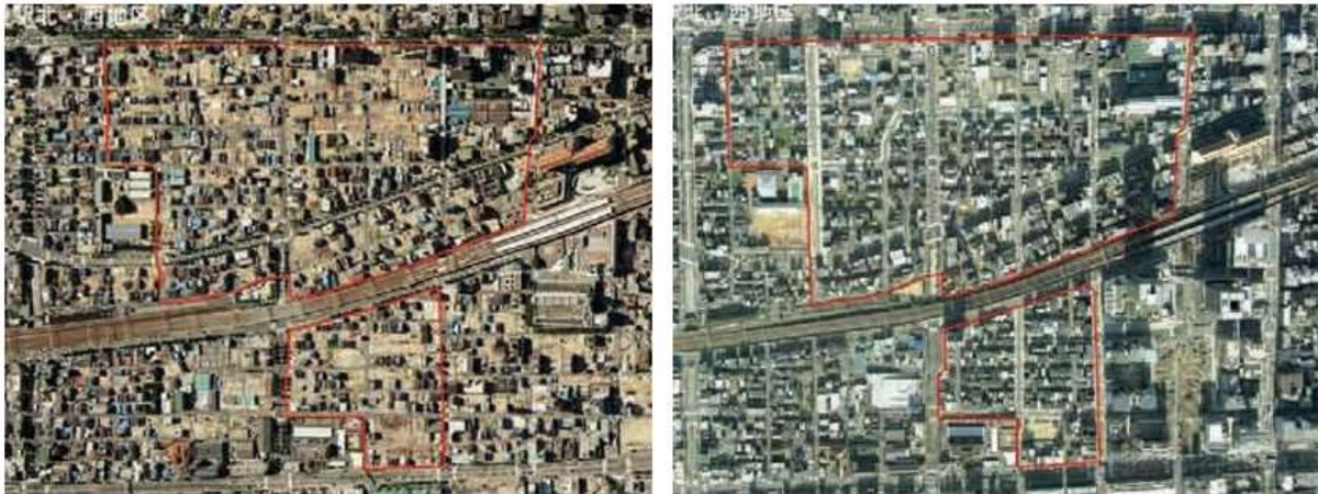
Figura 17 – Reconstrução Estação Rokkomichi 1995-2007, Kobe
