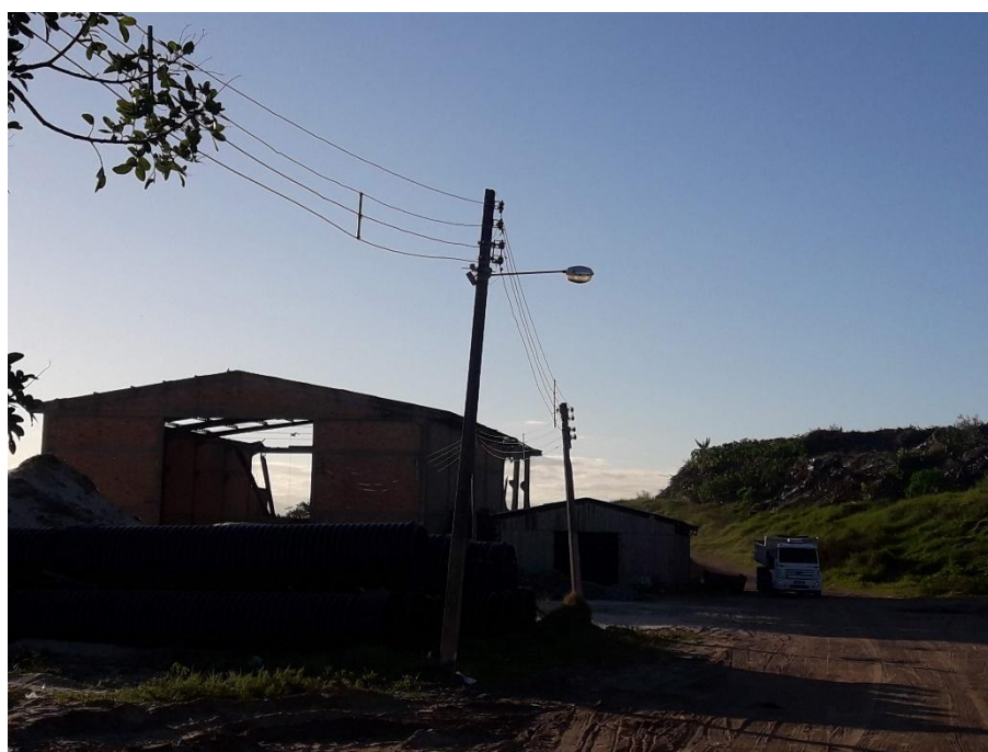
Figura 7 - Poste de iluminação interno
