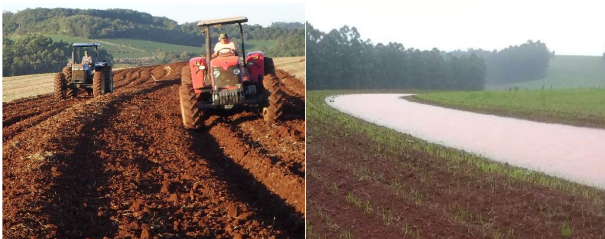
Figura 4. Construção do terraço base larga, em nível (A); Terraço construído armazenando água (B).
