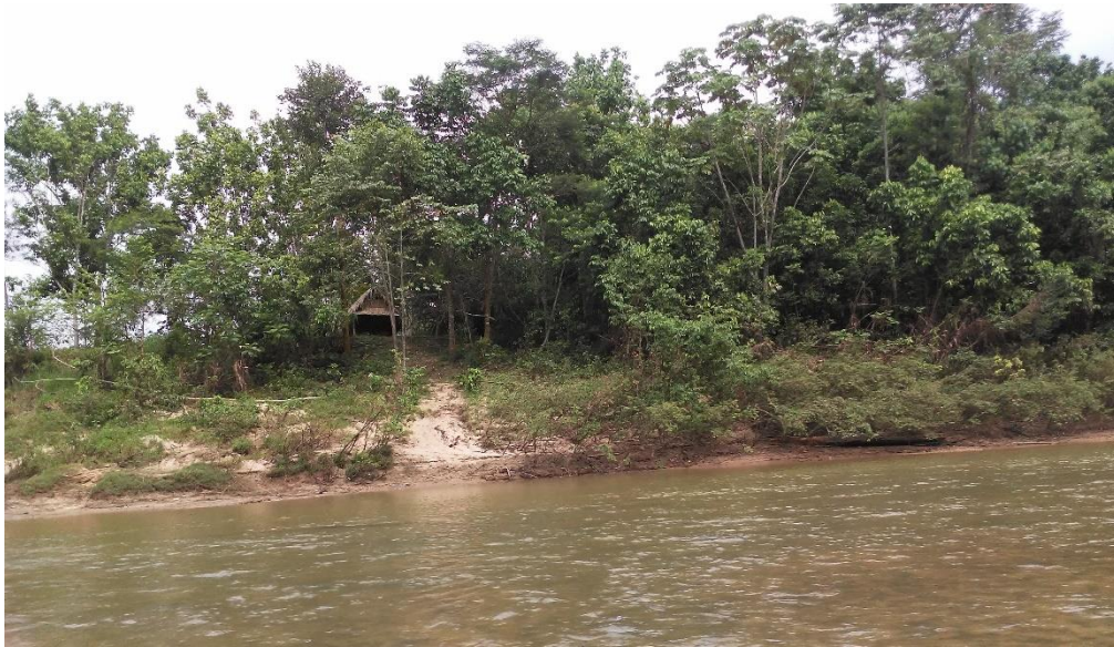
Figura 3: Erosão na área de acesso à edificação.
