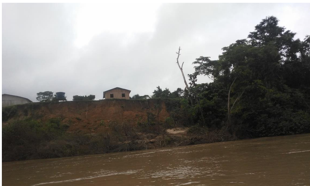
Figura 2: Erosão na área sem vegetação.
