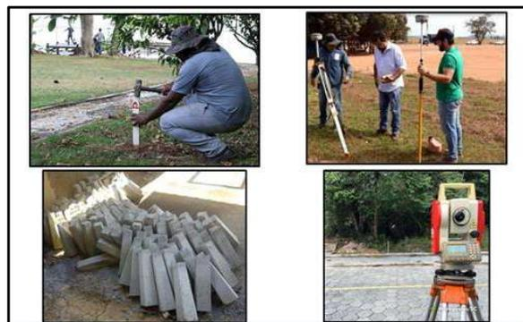
Fig. 9 - Levantamento, demarcação dos Lotes e implantação dos Piquetes.
