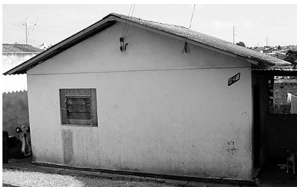
Figura 3 – Casa de concreto (fachada sul)
