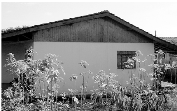
Figura 2 – Casa de fibrocimento (fachada sul)
