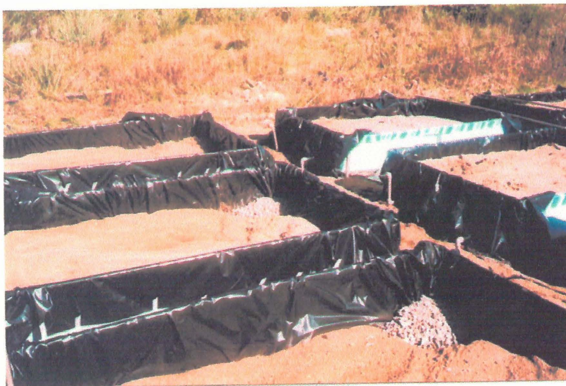
FIGURA 4.3 Etapa de preparação do projeto piloto: montagem dos acessórios hidráulicos.
