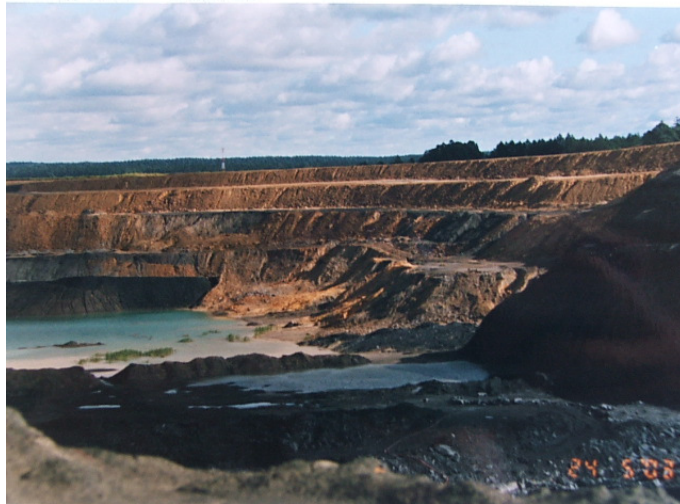
Figura 4. Geração de DAM à céu aberto na Mina do Recreio.
