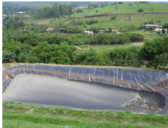
Figura 11. Primeira lagoa, anaeróbia, no aterro sanitário do Município de Campo Bom, RS.
