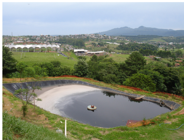
Figura 12. Segunda lagoa, aeróbia, no aterro sanitário do Município de Campo Bom, RS.
