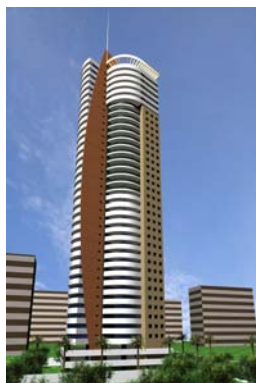
Figura 33: perspectiva artística do edifício Unique Residence (Loredo-Souza, 2008d)
