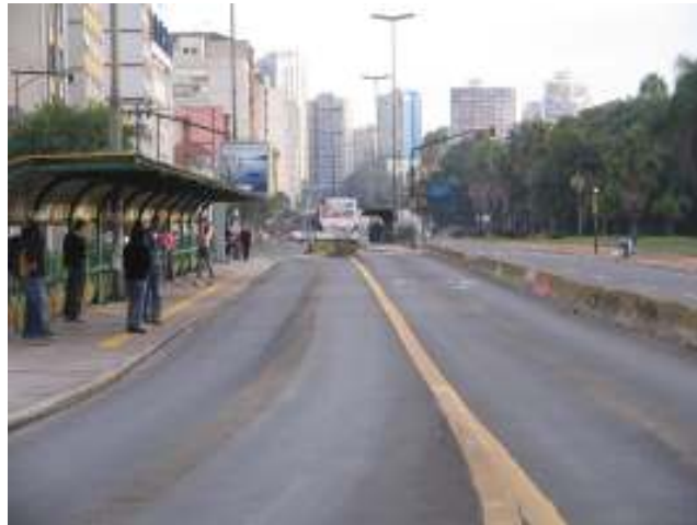
Figura 8 – Trecho executado em pavimento flexível
