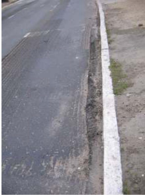
Figura 28 – Pavimento fresado
