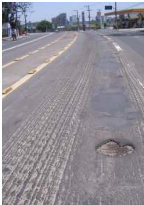
Figura 26 – Sequência de remendos e formação de panela
