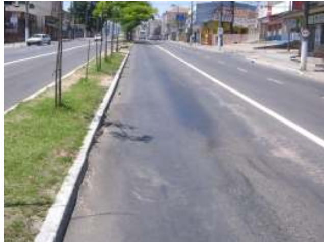
Figura 19 – Afundamento plástico nas trilhas de roda
