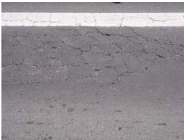
Figura 23 – Trincas couro-de-jacaré
