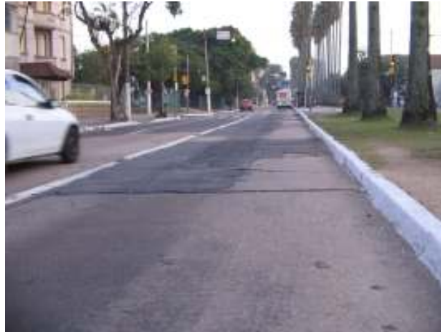
Figura 7 – Trecho executado em pavimento composto
