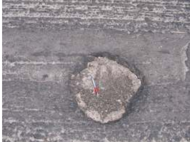
Figura 27 – Aproximação da panela do trecho com sequência de remendos
