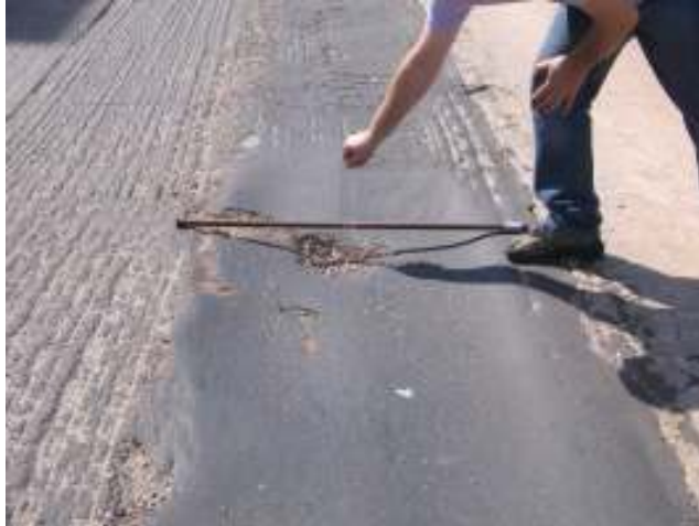
Figura 36 – Panela dentro de uma trilha de roda com profundidade de 9 cm
