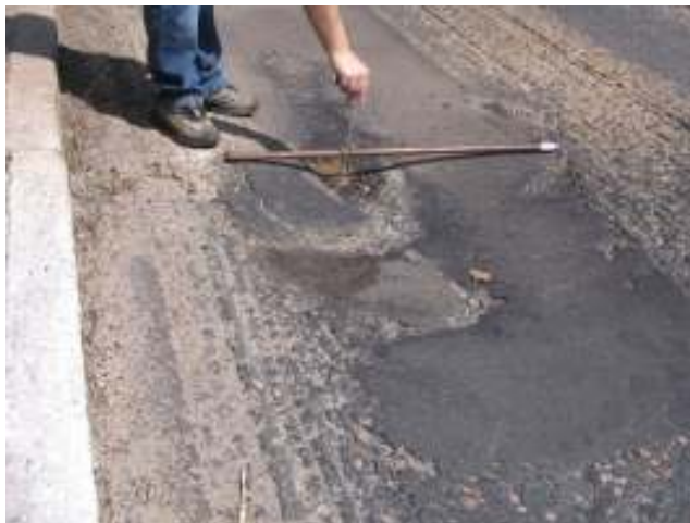
Figura 37 – Panela dentro de uma trilha de roda com profundidade de 9 cm
