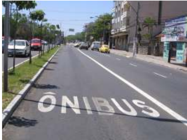
Figura 16 – Pavimento em boas condições na av. Bento Gonçalves
