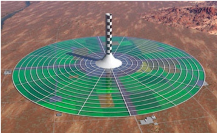
Figura 20: Chaminé térmica solar. Fonte: Enviromission
