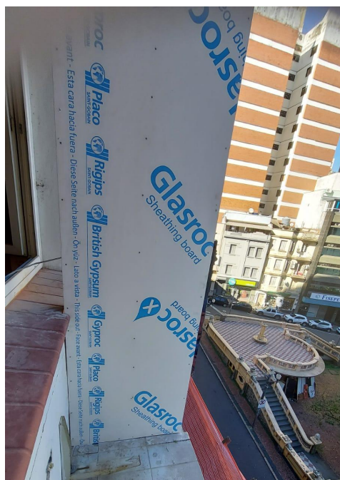
Figura 32- Plaqueamento do brise com chapa de gesso revestido indicado para fachadas
