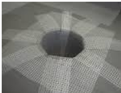
Figura 15 - Ilustração da tela aplicada no interior e entorno do ralo, pronta para receber nova demão de impermeabilizante.
