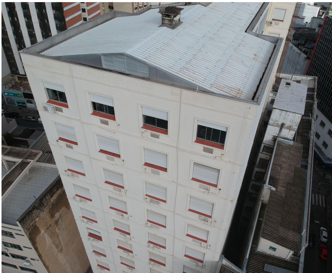
Figura 28 - Vista externa da edificação, anterior ao retrofit, mostrando a fachada Leste
