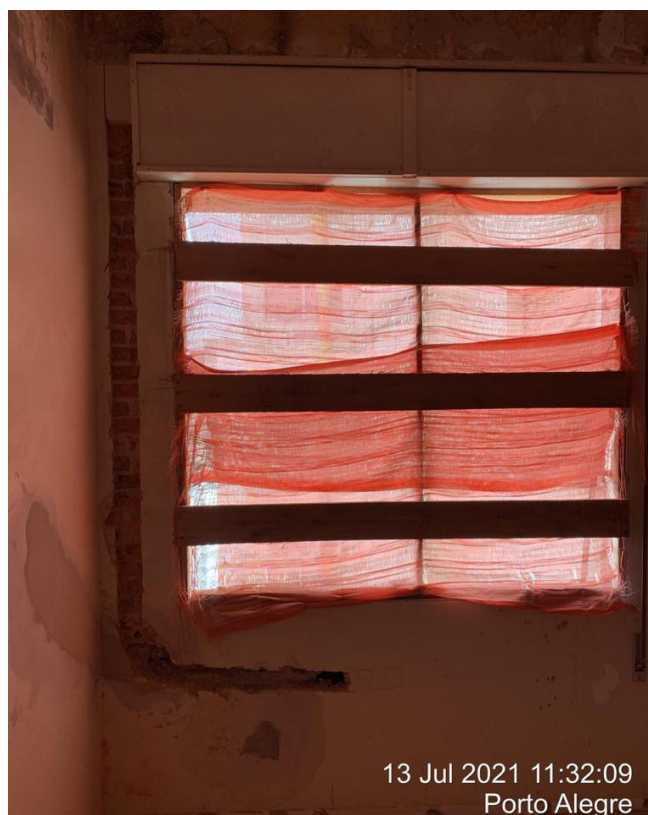
Figura 23 - Vão de janela em apartamento de final 16 após remoção de esquadria existente.
