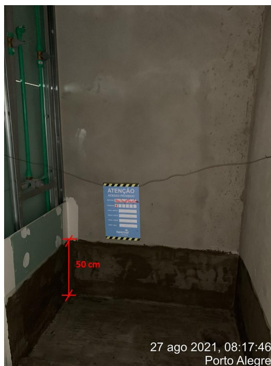
Figura 8 - Impermeabilização da área de box até a altura de 50cm.
