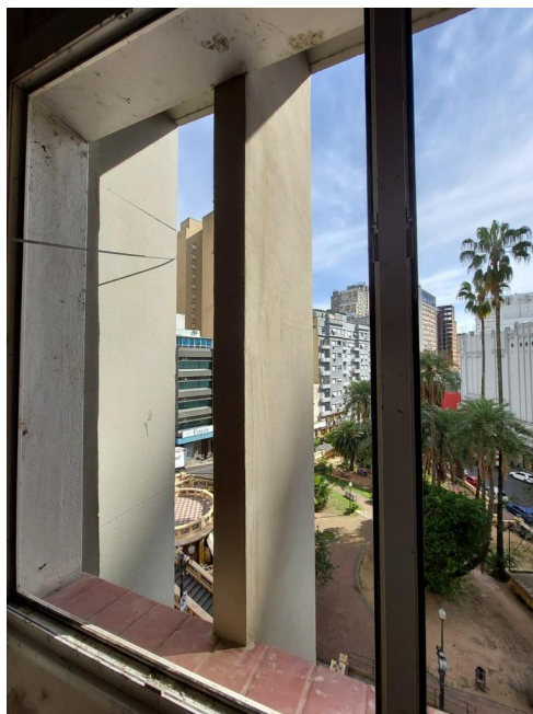
Figura 33 - Protótipo do brise após aplicação de massa cimentícia.
