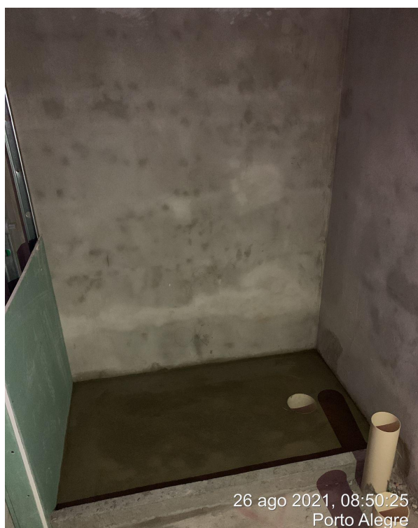
Figura 13 - Área de box pronta para receber a impermeabilização
