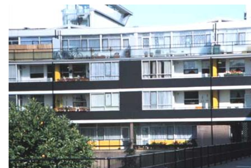
Figura 64 - imagens da proposta vencedora construída
