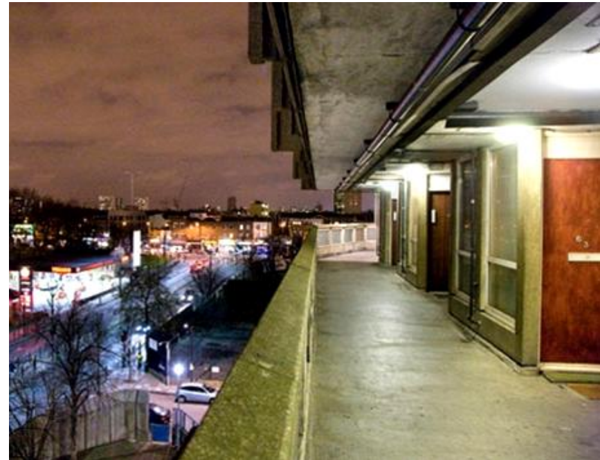
Figura 103 - Foto do deque no bloco mais alto
