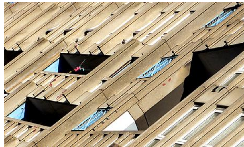
Figura 102 - Detalhe da fachada
