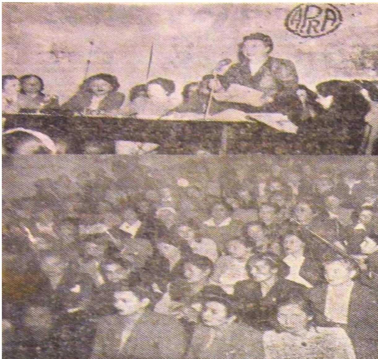
Figura 71. Prosiguen activamente los trabajos en la Convención Nacional de Mujeres Apristas. Doris Clark, fundamentando la ponencia de la Comisión de Cultura. En la mesa directiva de izquierda a derecha: Ollé de Bieberach, Mary de Soldí, Leticia Struque, Magda Portal, Lila Rivadeneira, Doris Clark, Imelda Lindo y Maria Julia Luna. Abajo: un aspecto del Plenario. La Tribuna , 21 de noviembre de 1946.
