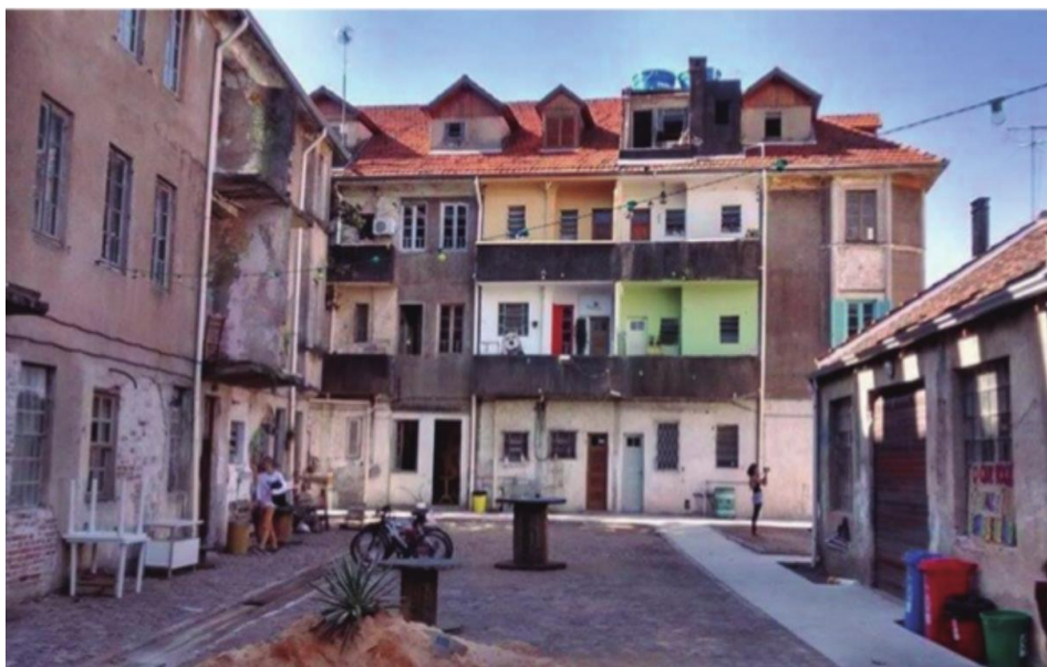
Figura 1 - Edificações que compõem a ACVF. Início da revitalização do prédio.
