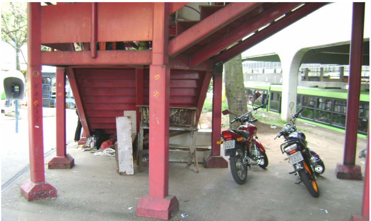
Figura 37: espaço sob as escadas de acesso à estação Canoas no lado oeste
