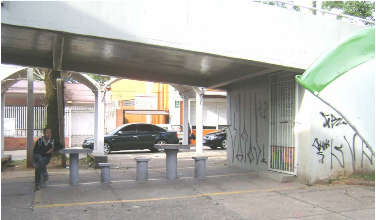
Figura 36: espaço sob a rampa de acesso à estação Canoas no lado oeste
