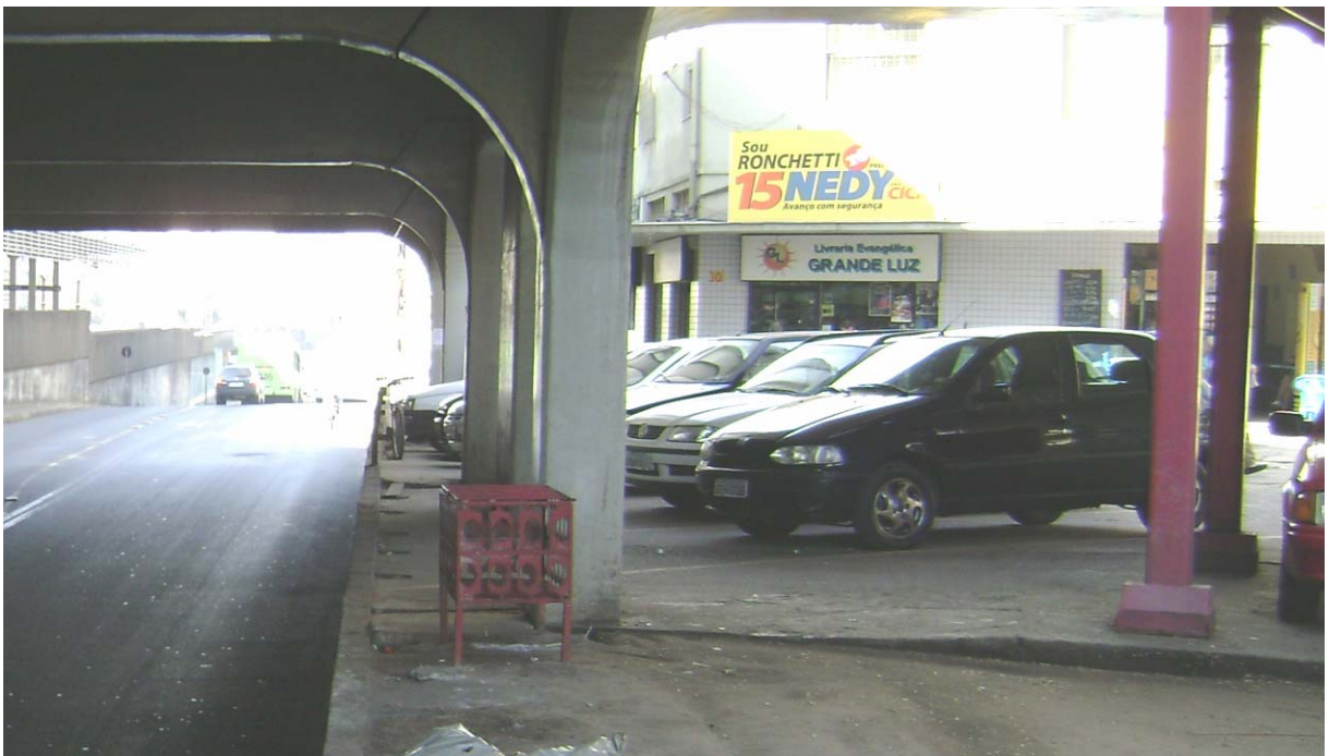
Figura 35: espaço ao lado da rampa de acesso à estação Canoas no lado oeste, utilizado como estacionamento de automóveis
