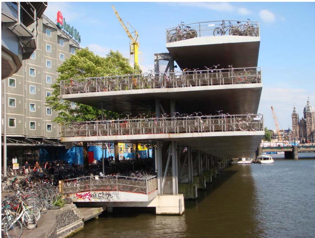
Figura 3: bicycletário junto a estação em Amsterdam
