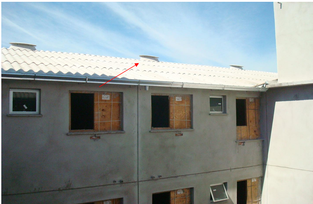
Figura 25: cumeeiras de lanternins espaçadas (CAIXA ECONÔMICA FEDERAL, 2007)
