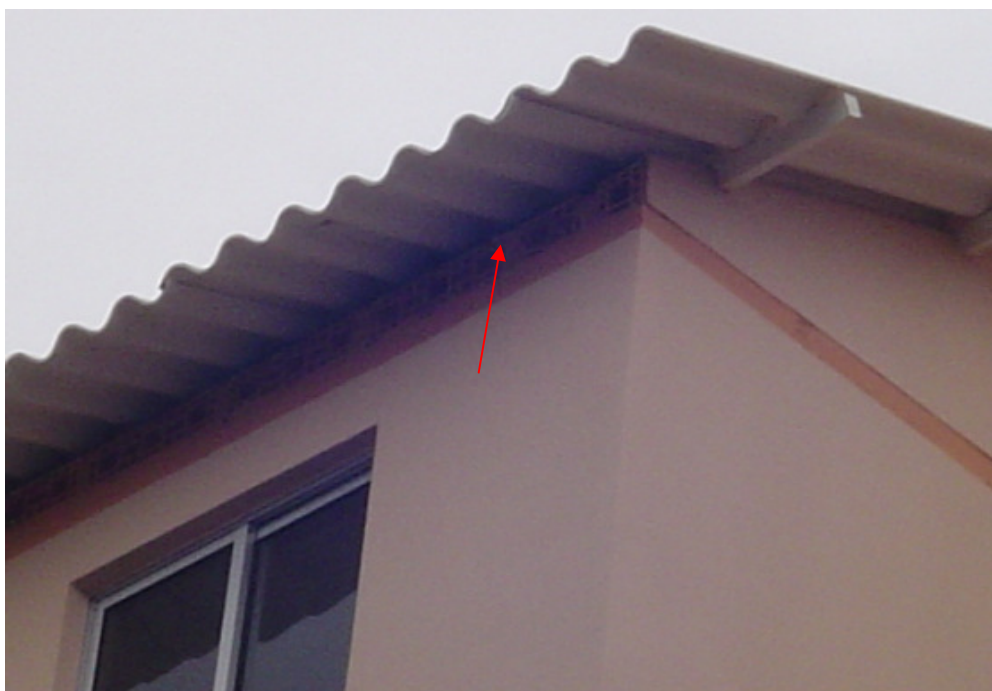
Figura 31: ventilação frontal junto ao beiral (CAIXA ECONÔMICA FEDERAL, 2007)
