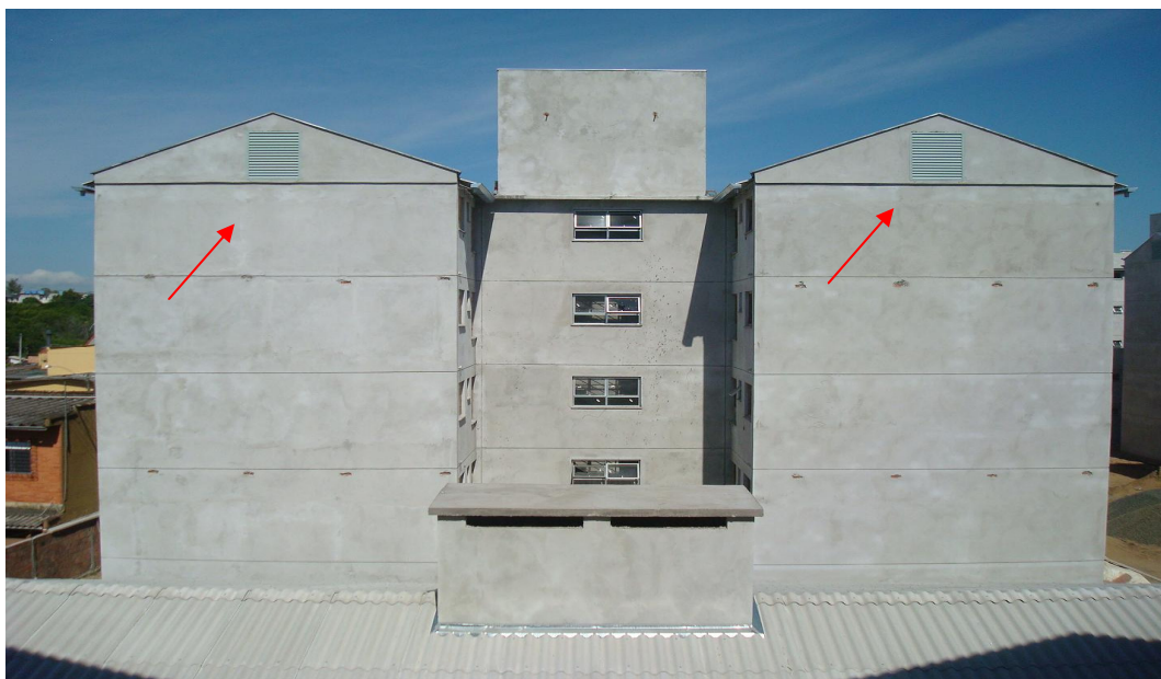
Figura 27: venezianas de alumínio nas empenas (CAIXA ECONÔMICA FEDERAL, 2008)
