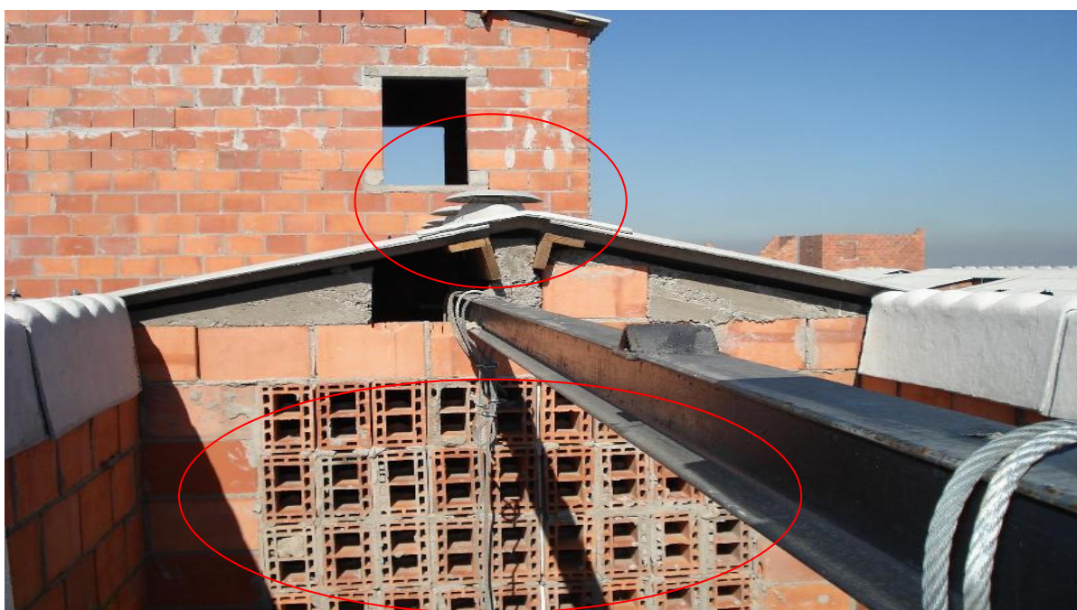
Figura 24: ventilação cruzada típica dos empreendimentos do PAR (CAIXA ECONÔMICA FEDERAL, 2007)
