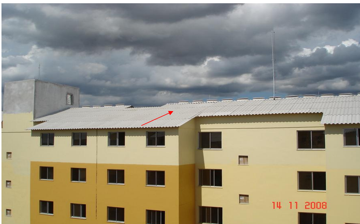
Figura 26: cumeeiras de lanternins próximas (CAIXA ECONÔMICA FEDERAL, 2008)
