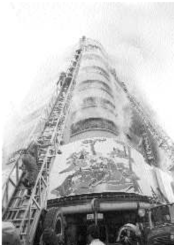
Figura 6 – Incêndio das Lojas Renner (INCÊNDIOS..., 2009)
