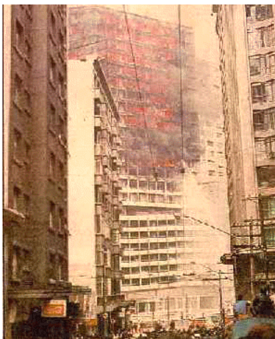
Figura 3 – Incêndio do Edifício Joelma (BOMBEIROS EMERGÊNCIA, 2009b)
