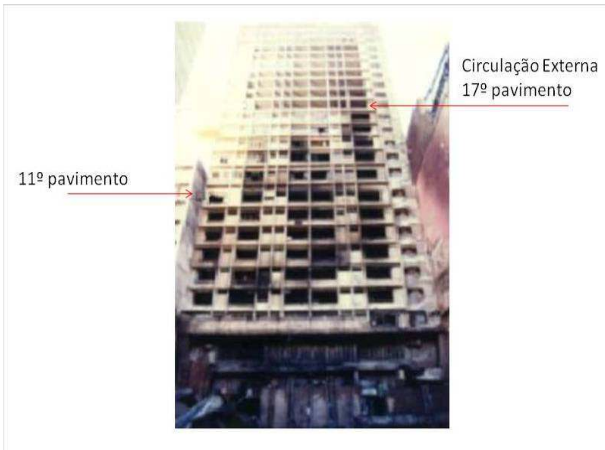
Figura 12 – Fachada posterior do Condomínio Edifício Cacique após o sinistro (trabalho não publicado 11 )
