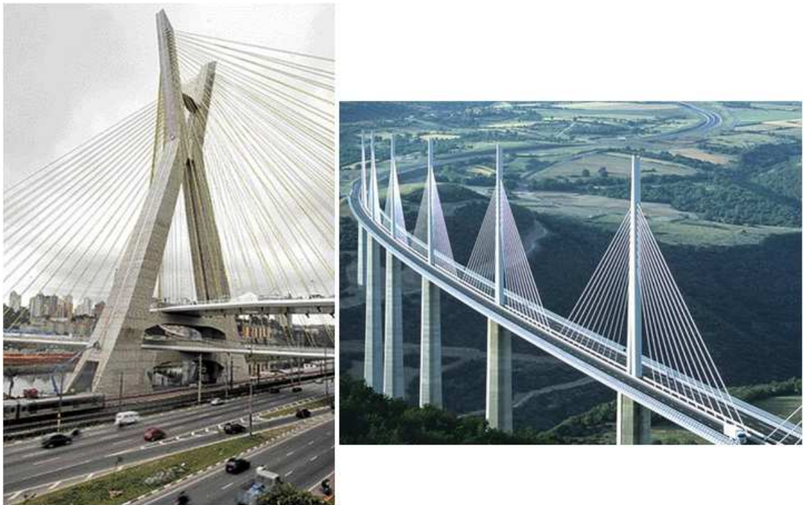
Figura 2: estaiamento de ponte – Ponte Octávio Frias de Oliveira-Brasil (à esquerda) e Viaduto de Milau-França (à direita)
