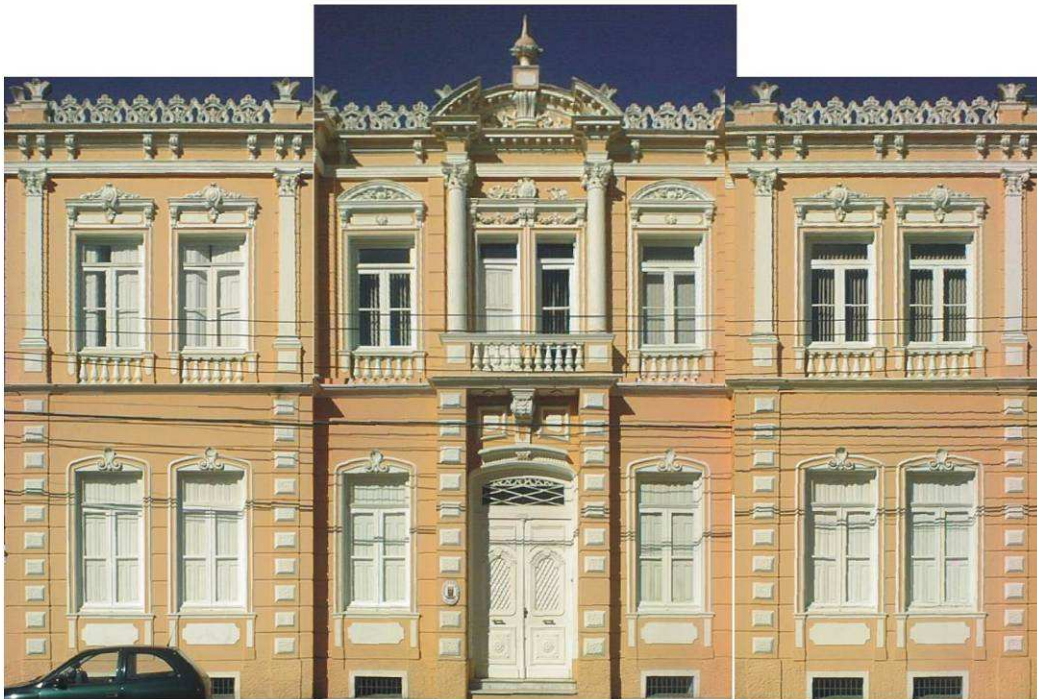
Figura 5-4 Conjunto de fotos ortorretificadas para reconstituição de fachada.
