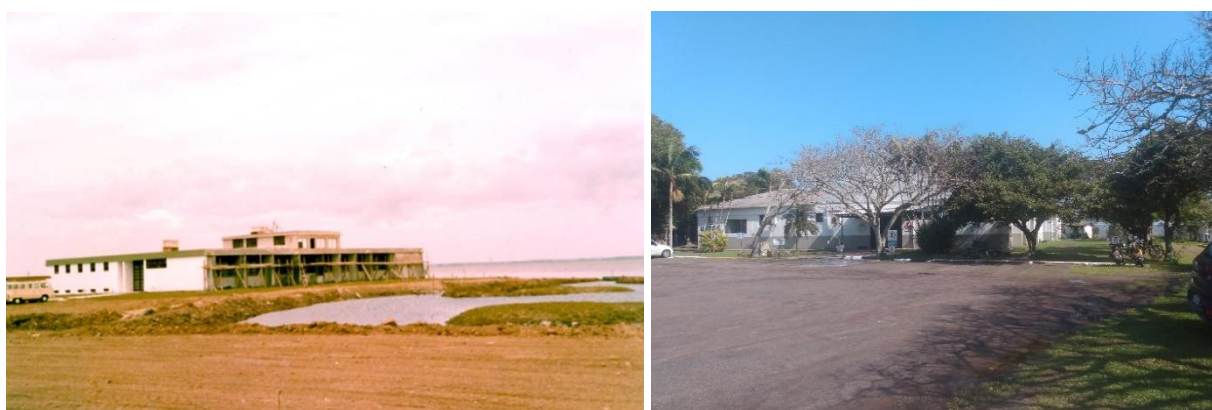
Figura 1. Vista do prédio administrativo do CECLIMAR, no período de construção, início da década de 80 (foto esquerda) e atualmente (foto direita). Fonte: arquivo do CECLIMAR e autor (2023).
