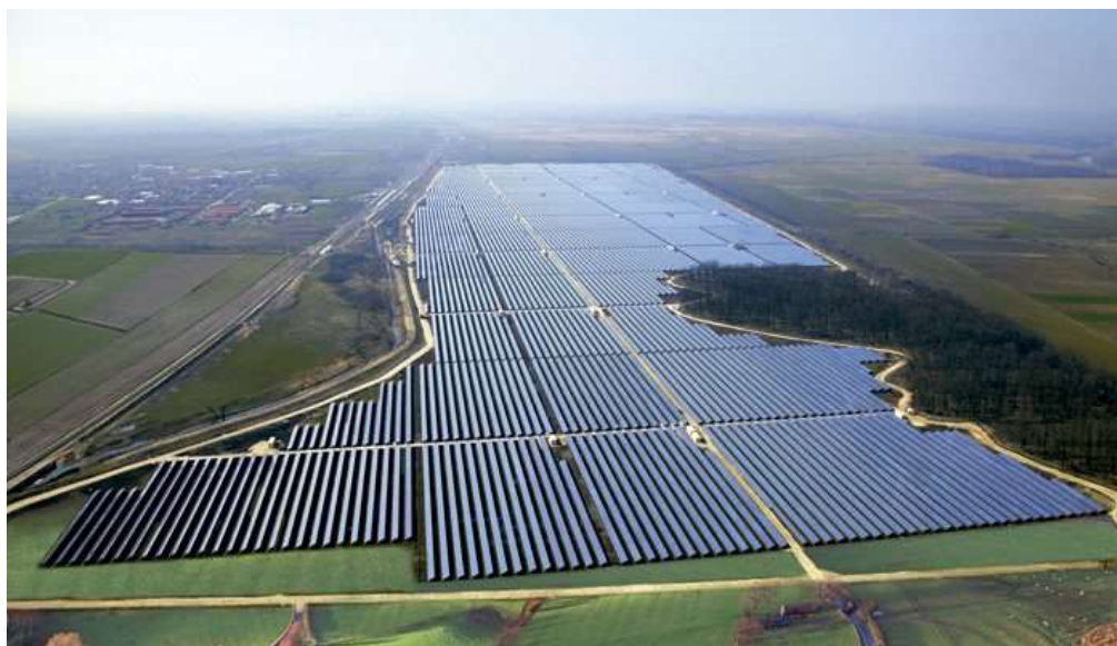
Figura 4: Usina fotovoltaica São Gonçalo, no Piauí, maior potência nominal do Brasil.
