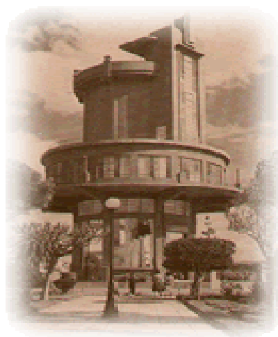
Figura 01 – Estação de Tratamento
