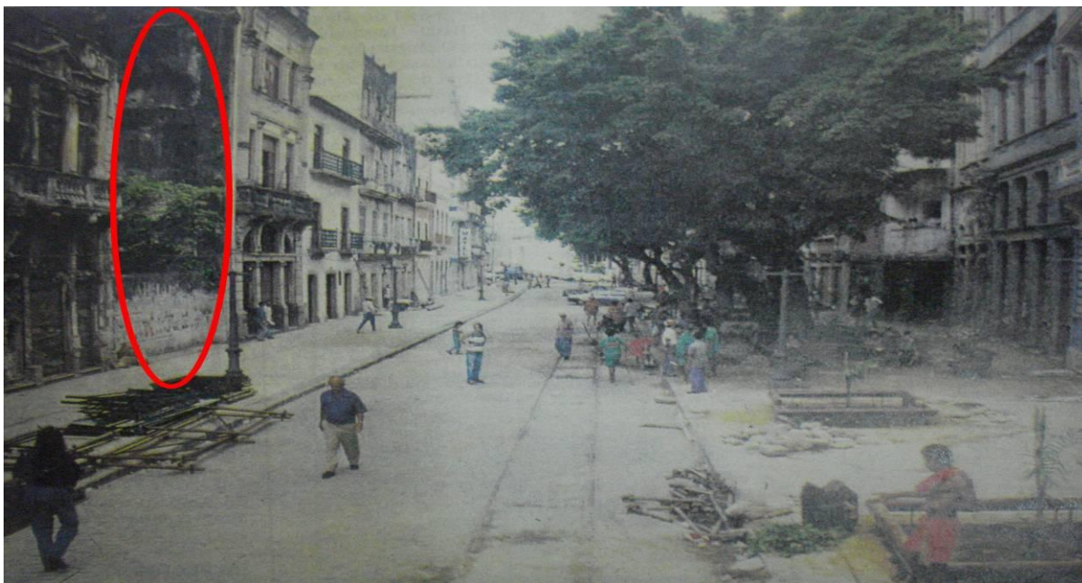
Figura 7: Início das intervenções físicas na Rua do Bom Jesus em 1994.
