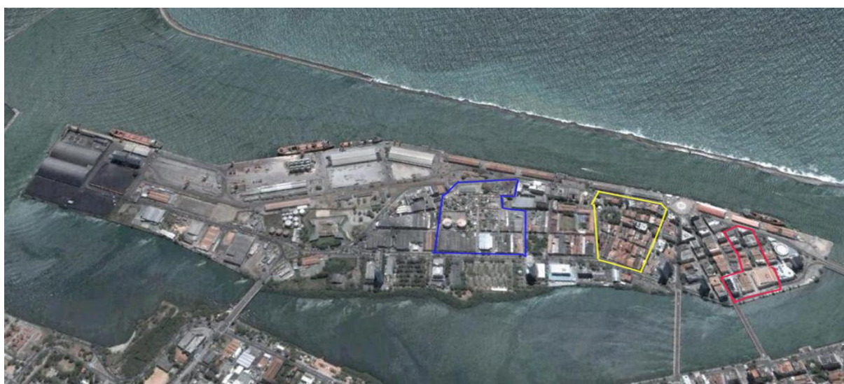
Perímetro do Pólo Pilar Perímetro do Pólo Bom Jesus Perímetro do Pólo Alfândega
