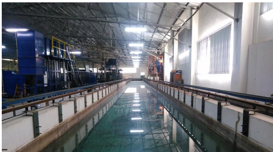
Figura 5 - Vista do Canal de Calibração em sua extensão total de 60,00 m no Pavilhão Marítimo do IPH/UFRGS
