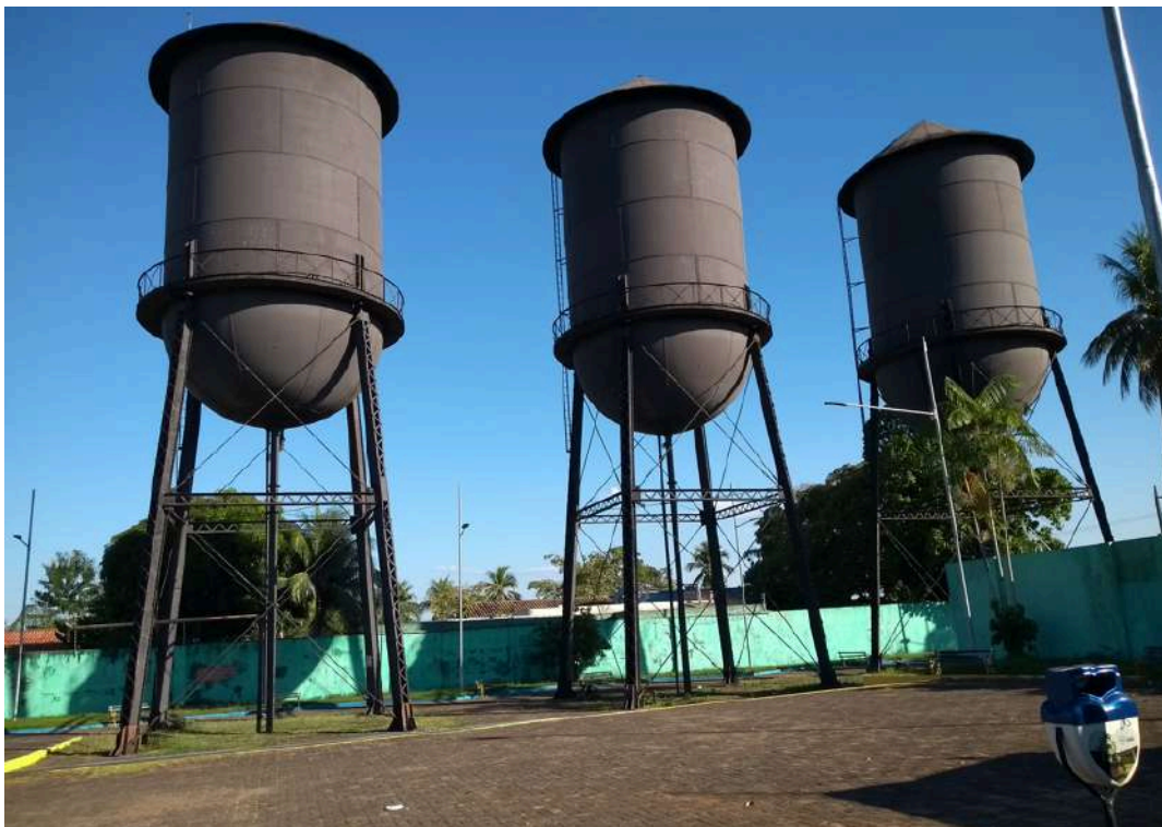
Figura 51 – Fotografia das Três Caixas D'Água
