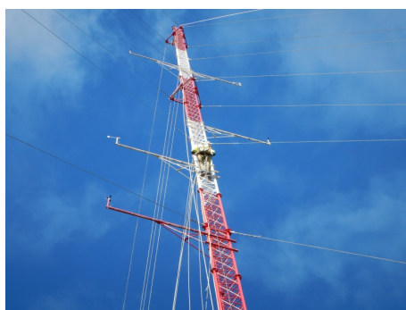
Figura 2.5 – Torre anemométrica treliçada. Fonte: (3DOTENERGY, 2023).
