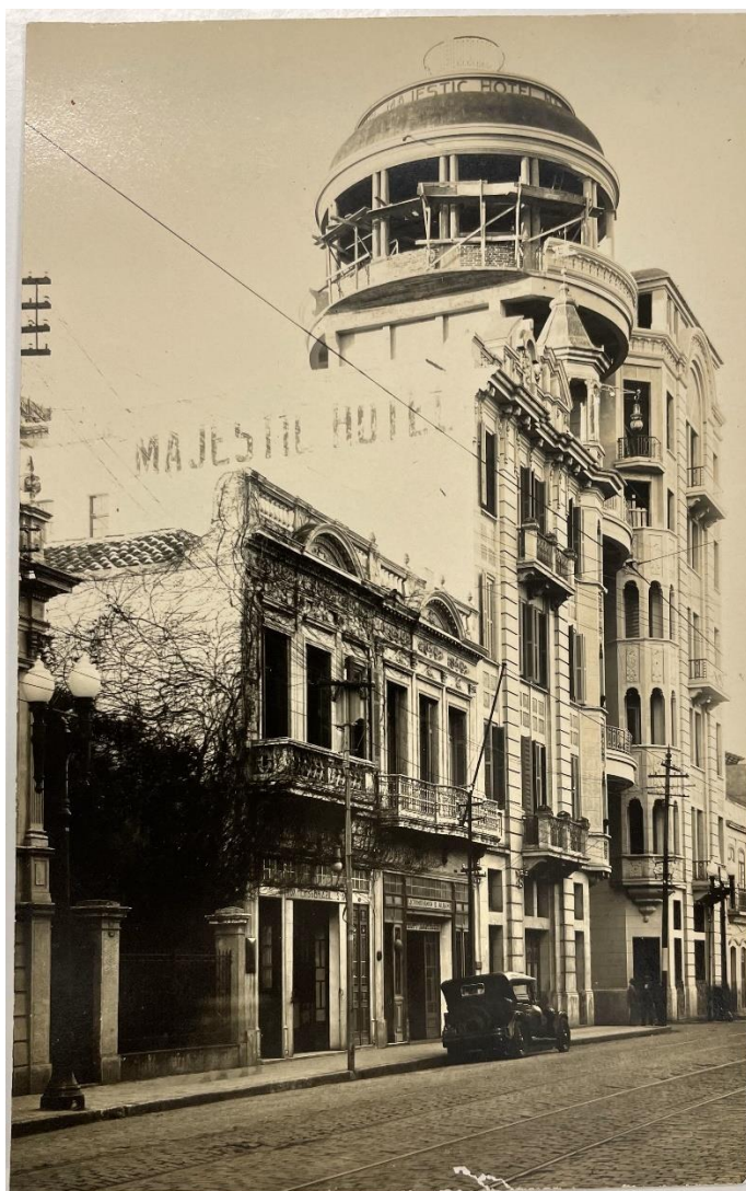
Figura 15 – Hotel Majestic em construção
