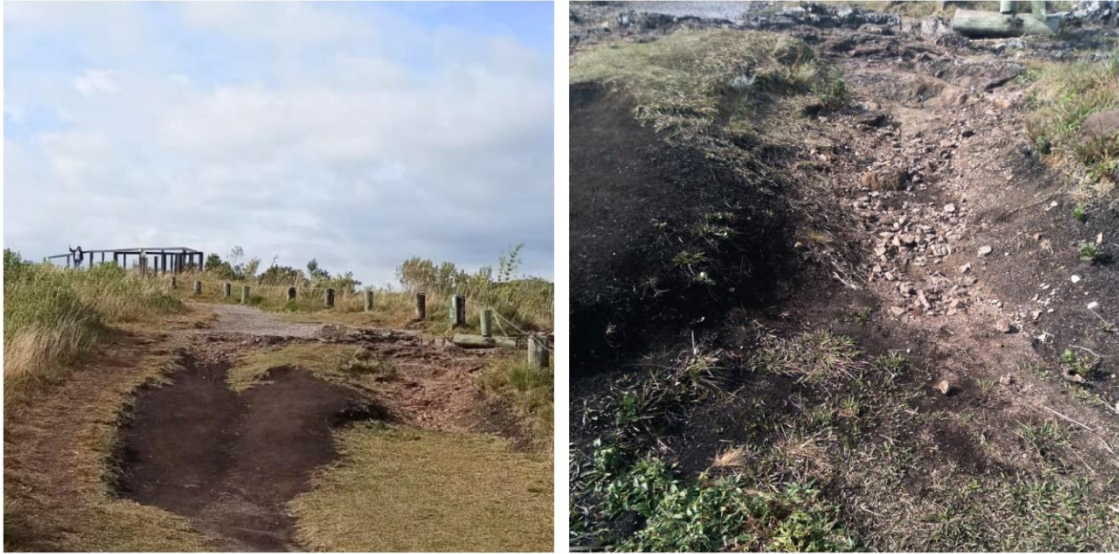
Figura 10: Figura ilustrativa dos processos erosivos (ponto de erosão), localizados na Trilha do Cotovelo.
