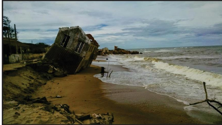
Figura 105 – Praia de Atafona em São João da Barra-RJ, em processo de erosão acelerada. (fonte: https://parahybano.com.br/wp-content/uploads/2015/03/casa-caindo.jpg )
