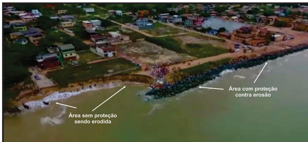
Figura 104 – Estrutura de defesa permanente contra erosão e o deslocamento do problema para outra área.
