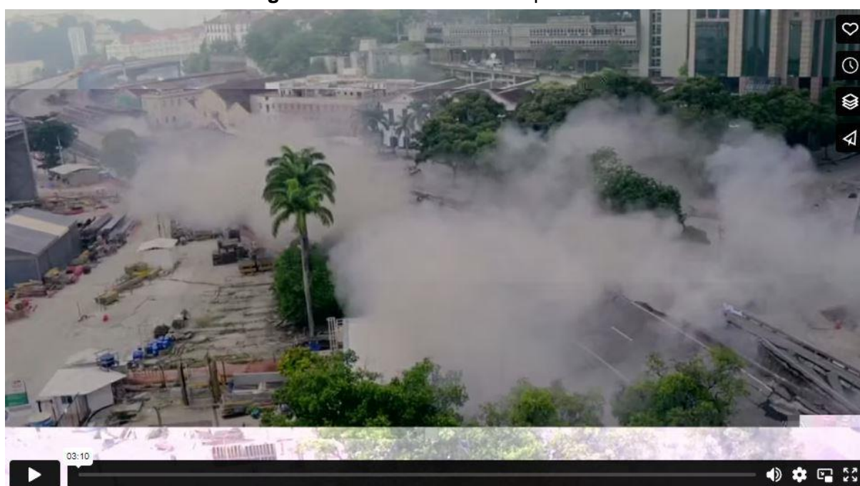
Figura 46 – Cinema Lascado: perimetral
