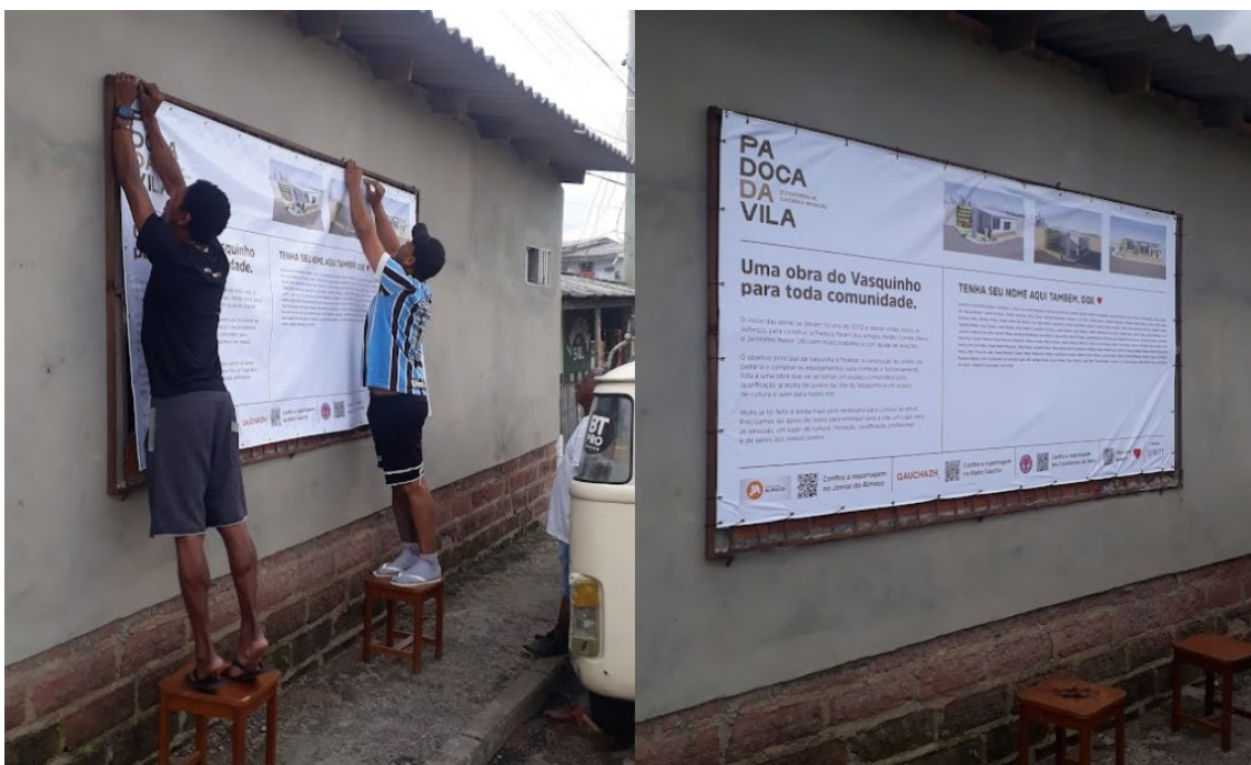
Figura 25: Instalação da primeira lona.
