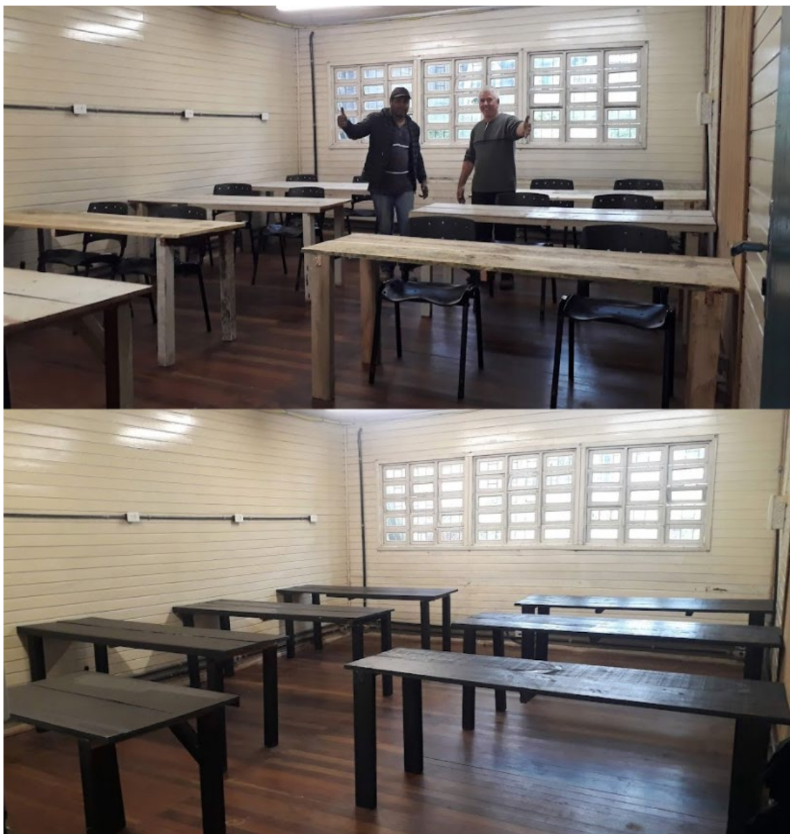
Figura 70: Reforma sala V.
