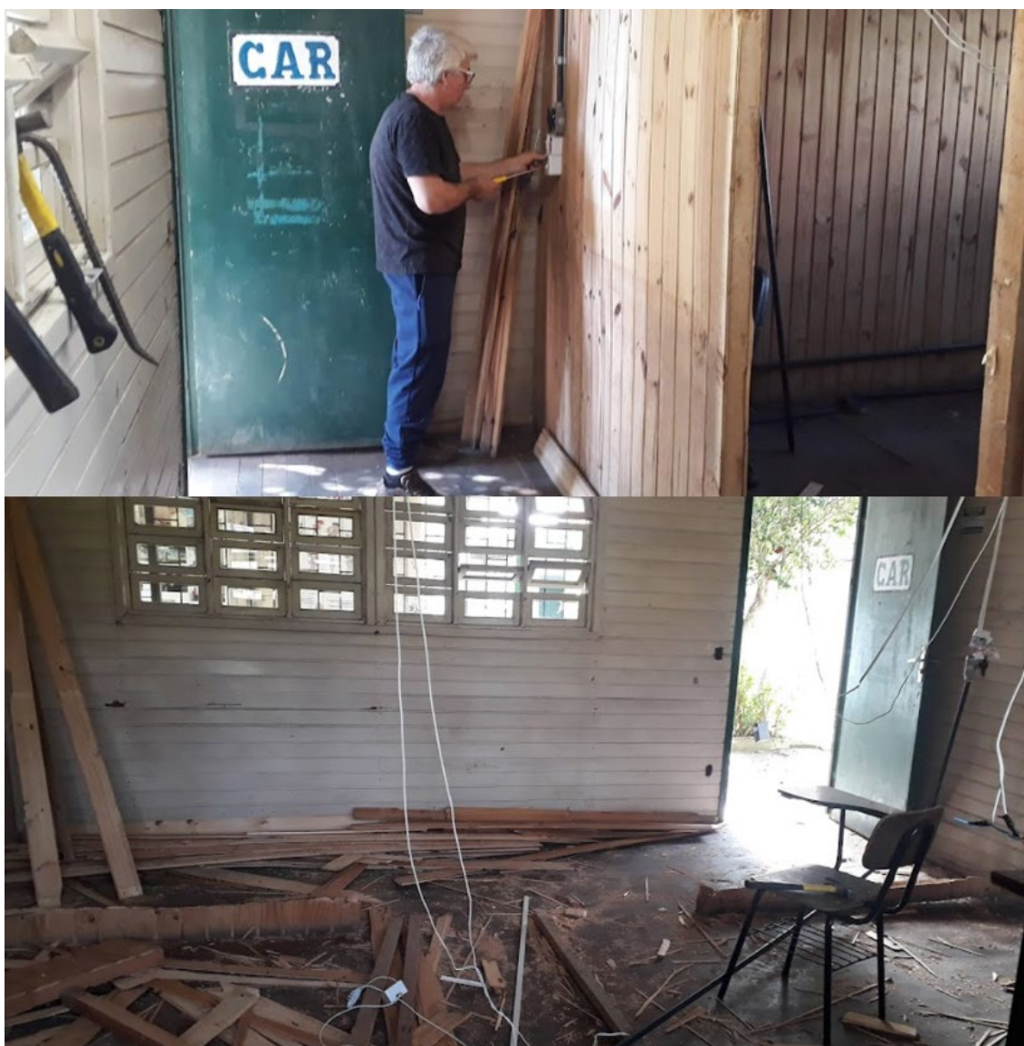
Figura 66: Reforma sala I.
