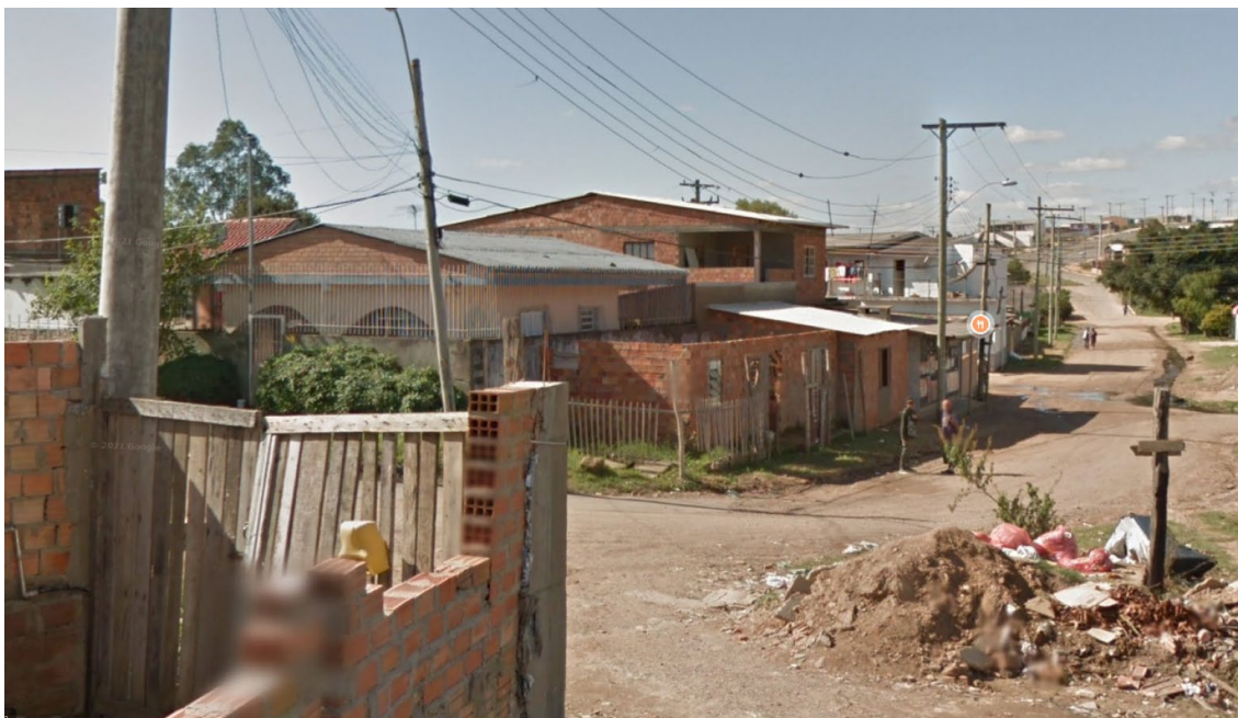
Figura 12 - Início das obras em 2012.
