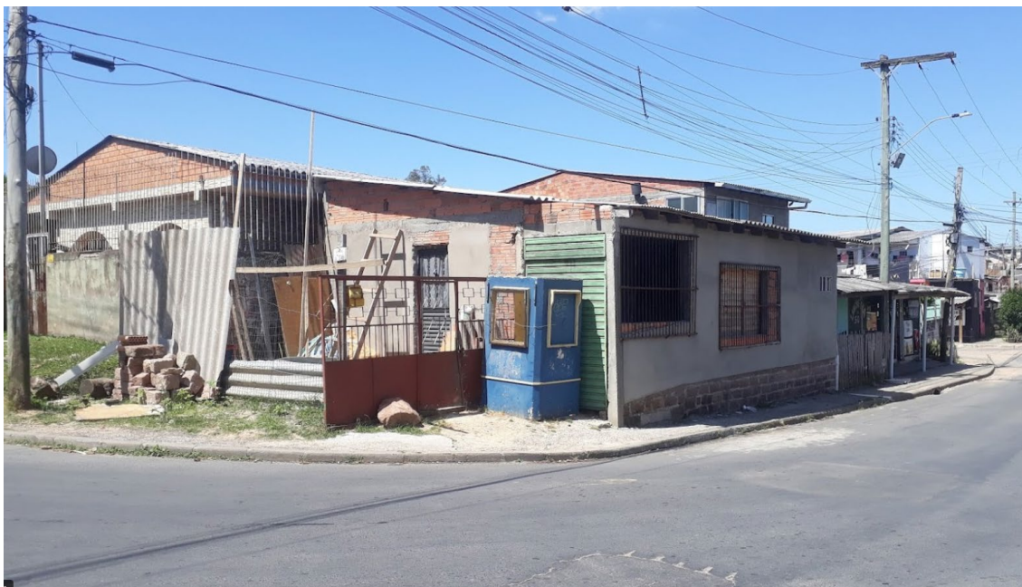
Figura 16 - Estado atual das obras.
