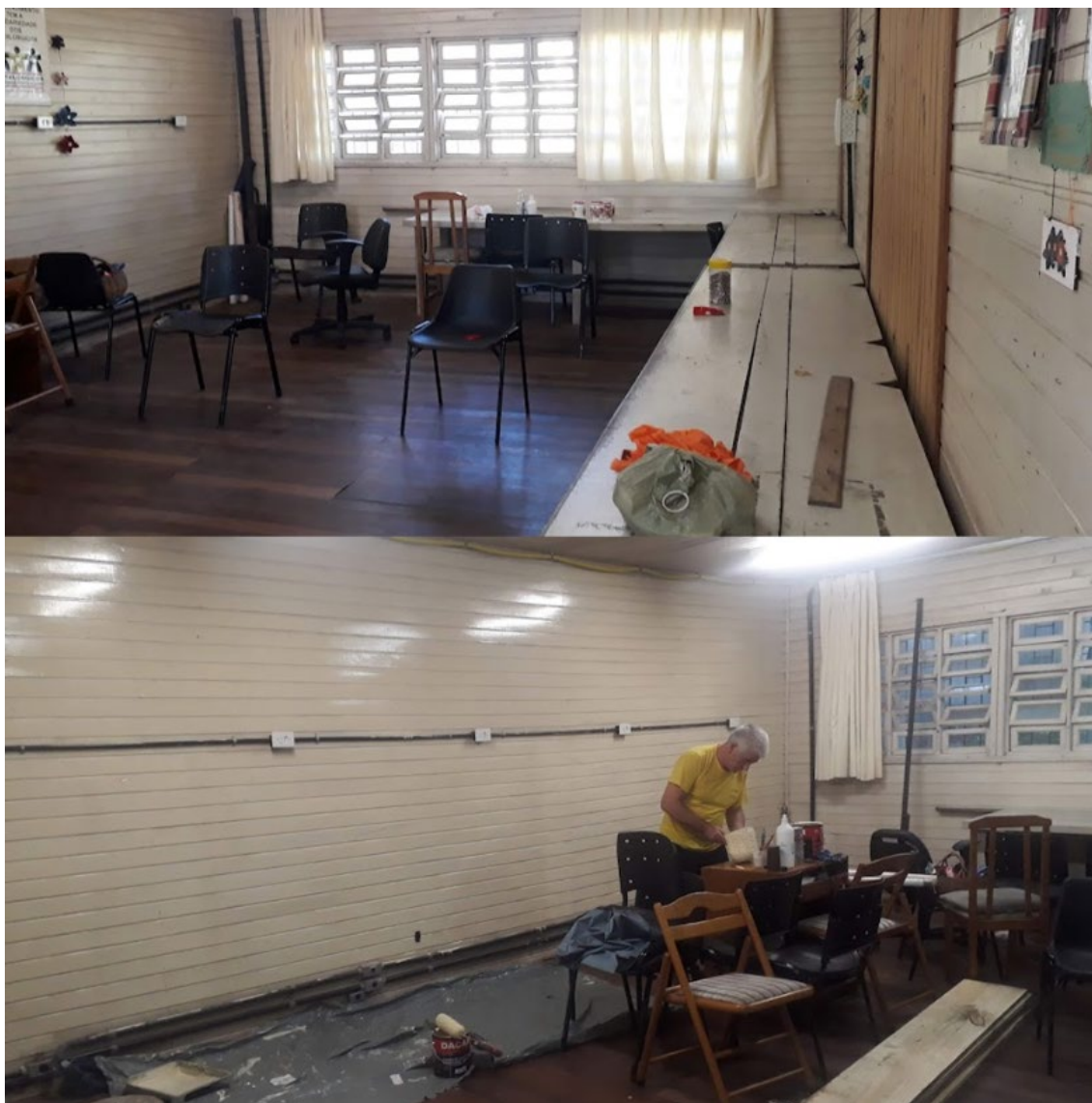
Figura 68: Reforma sala III.
