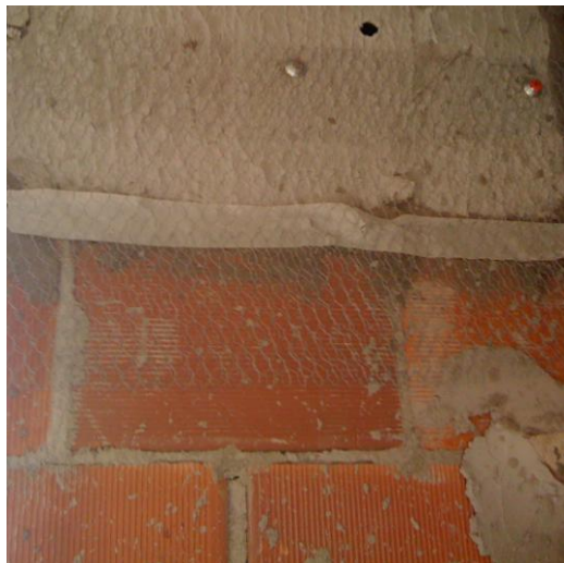
Figura 18: reforço do tipo ponte de transmissão
