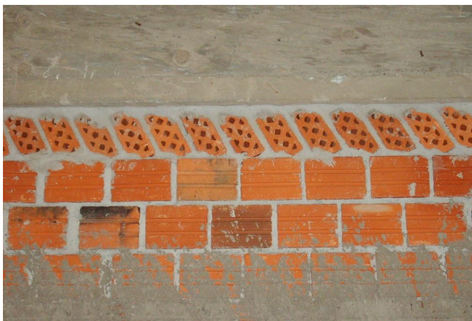
Figura 15: encunhamento com tijolos furados inclinados
