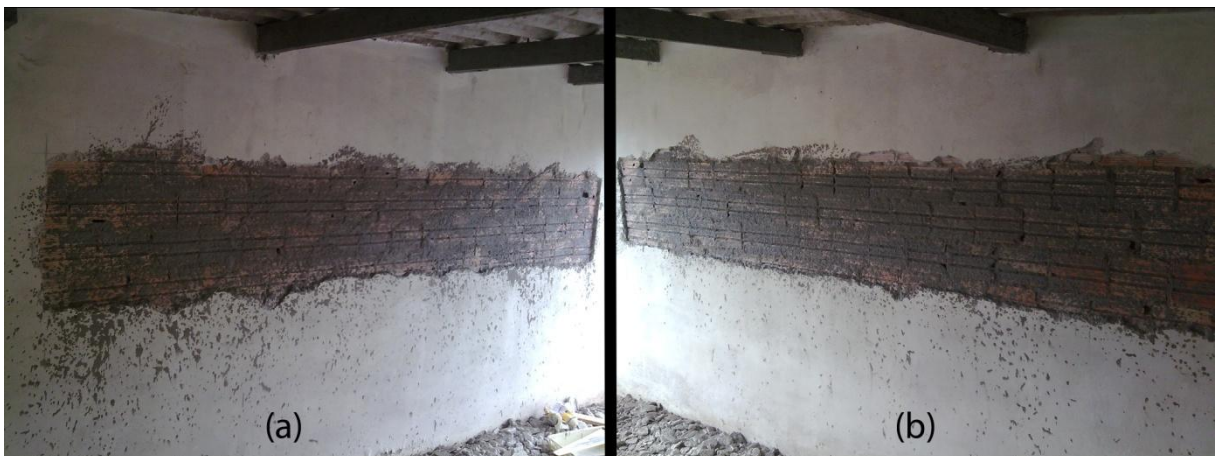
Figura 26: vista do chapisco lançado com colher sobre alvenaria de tijolos seis furos (a) parede A (b) parede B
