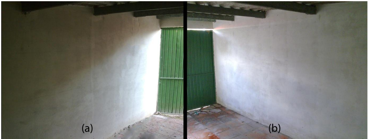
Figura 23: paredes escolhidas para a realização dos ensaios (a) parede A (b) parede B
