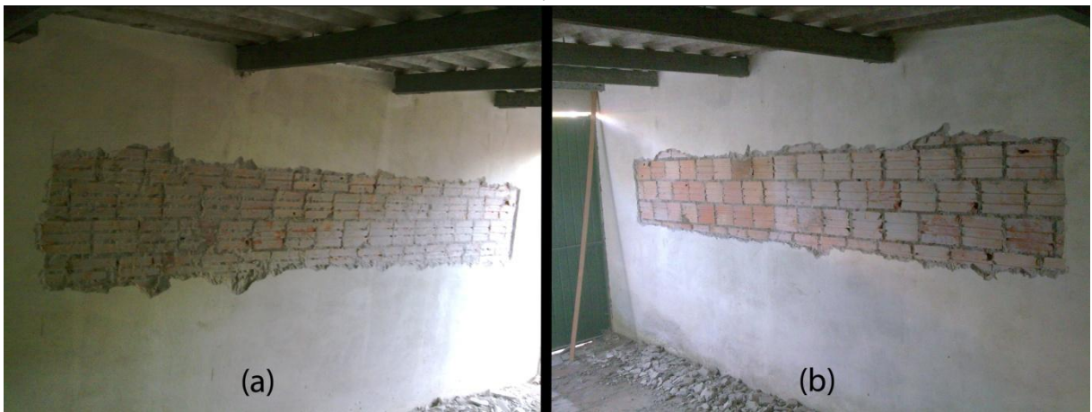
Figura 24: preparo de superfície: remoção do revestimento existente nas paredes a serem ensaiadas (a) parede A (b) parede B
