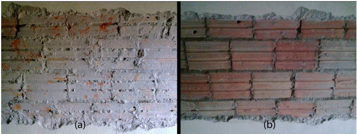
Figura 25: preparo de superfície: limpeza dos resquícios do revestimento removido (a) antes da limpeza (b) depois da limpeza
