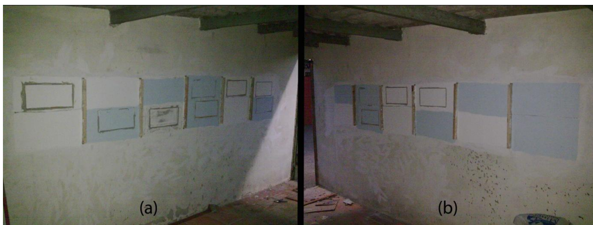
Figura 28: vistas das paredes com os acabamentos executados (a) parede A (b) parede B
