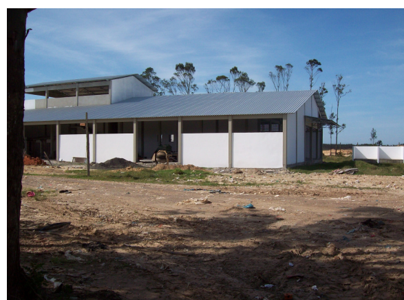
Figura 4 - Futuras Instalações da Usina de Triagem de Lixo Imagem: da autora.
