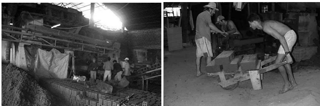
Figura 5 - Condições de trabalho verificadas em duas indústrias visitadas
