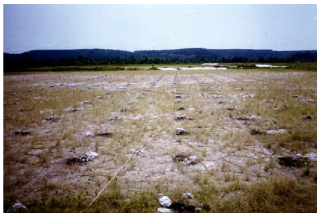
FIGURA 21 - Presença de vegetação após colocação de camada orgânica sobre a superfície da lagoa seca.
