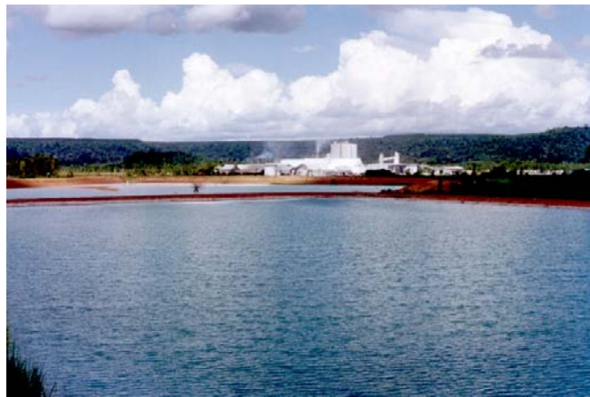
FIGURA 18 - Lagoa de sedimentação preenchida com a polpa de caulim.
