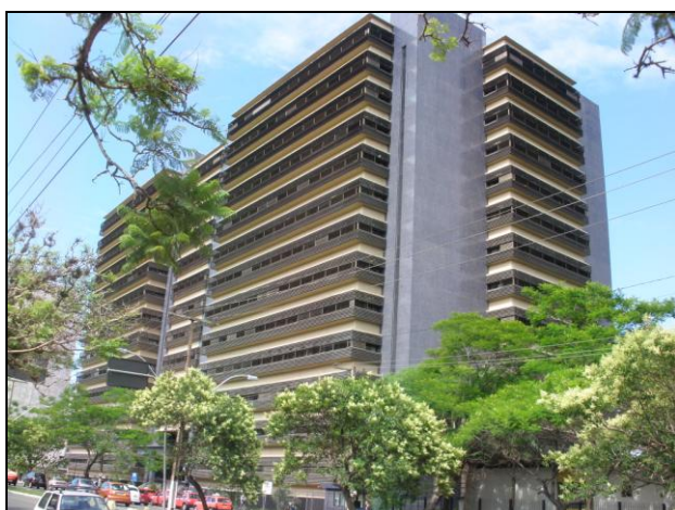
Figura 3: brise horizontal no edifício do Tribunal de Justiça
