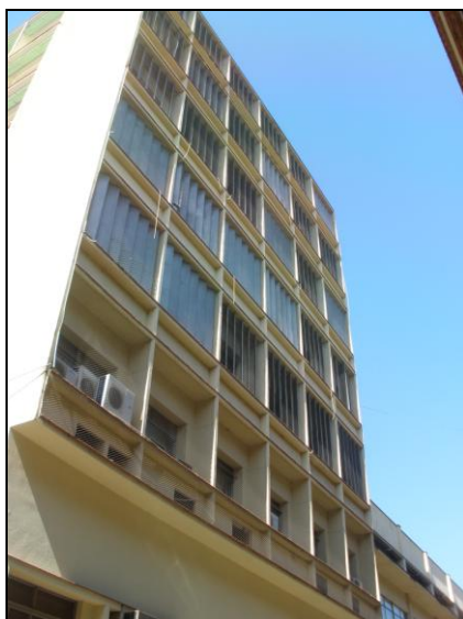
Figura 2: brise vertical no edifício da Reitoria da UFRGS
