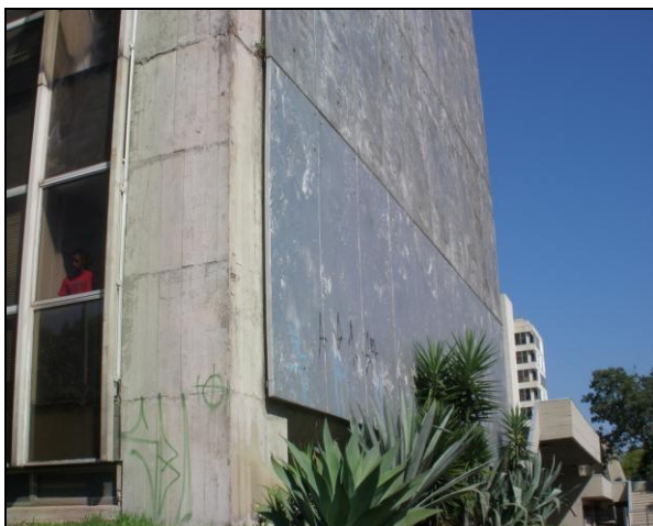
Figura 42: fachada Norte e painel de concreto
