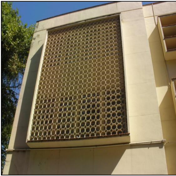
Figura 8: combogó no edifício do Anexo I da Reitoria da UFRGS
